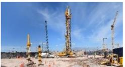
Pilotes CFA, bajo lodos y ensayos de carga, Aeropuerto Arturo Merino B.
