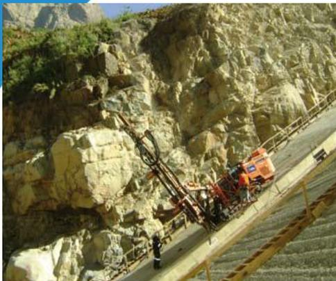
Inyecciones de impermeabilización en roca, Embalse Ancoa
