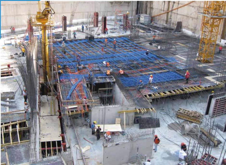
Losa Postensada Edificio de las Artes
