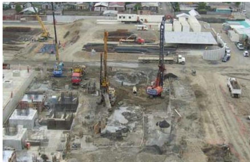
Pilotes pre-excavados Central Termoeléctrica Bocamina II
