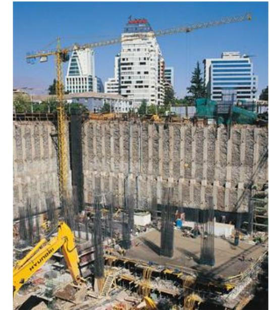
Anclajes postensados Edificio Isidora 3000
