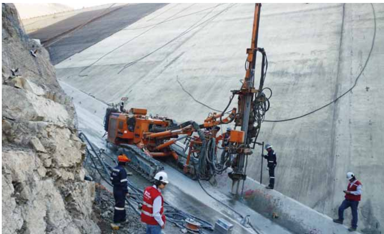
Inyecciones de Impermealización en Roca Embalse Ancoa, Linares - Chile
