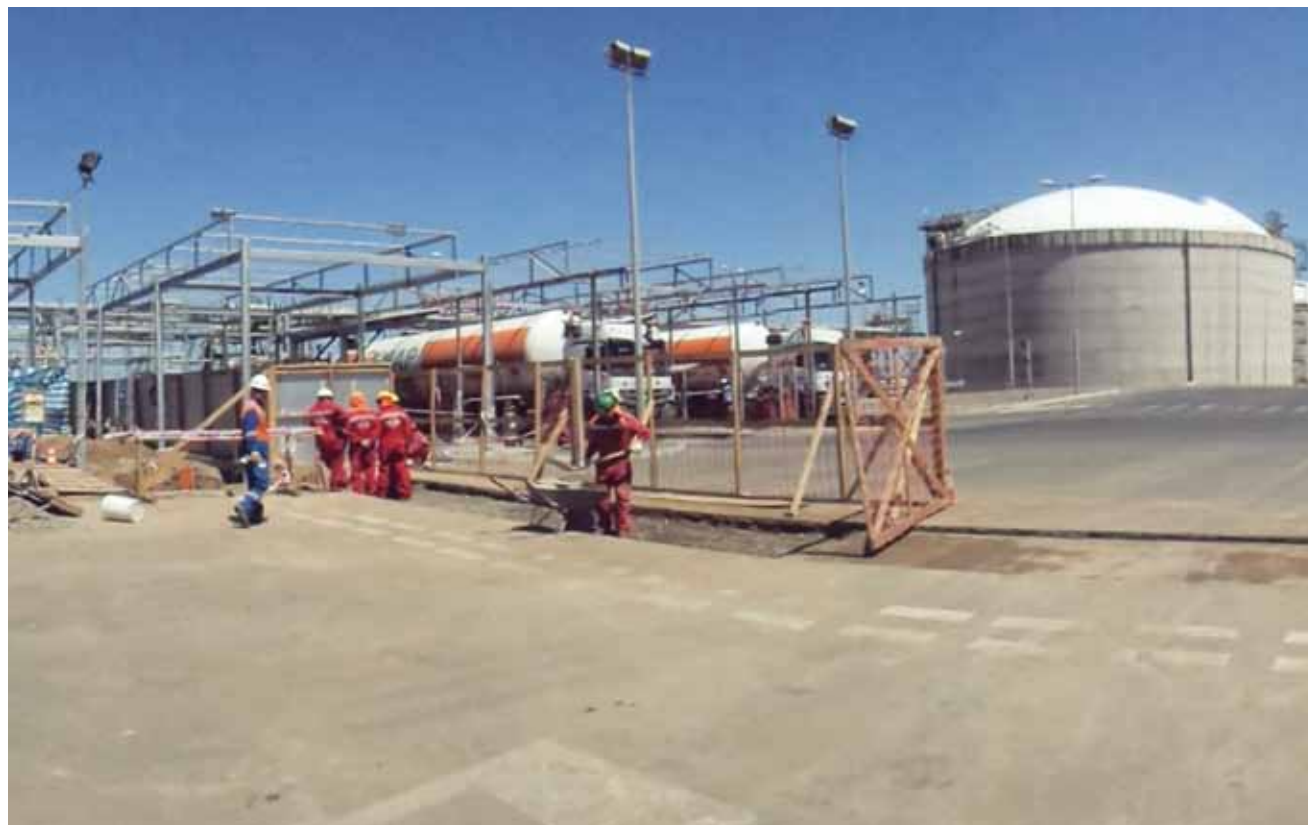
Ampliación Patio de Carga de Camiones, Gas Natural Licuado, Quintero - Chile
