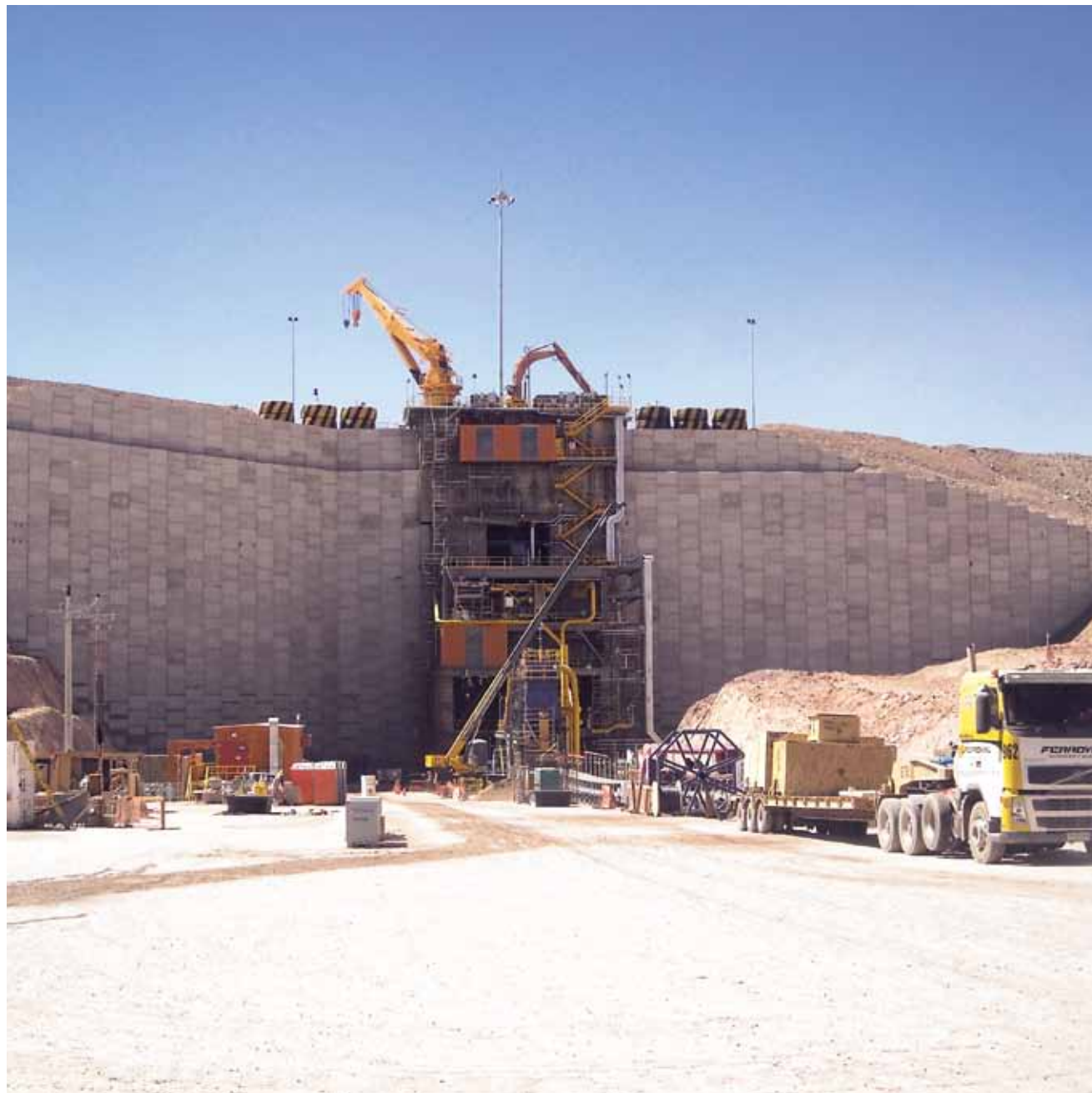
Muro Tierra Retenida Minera Esperanza, Sierra Gorda - Chile
