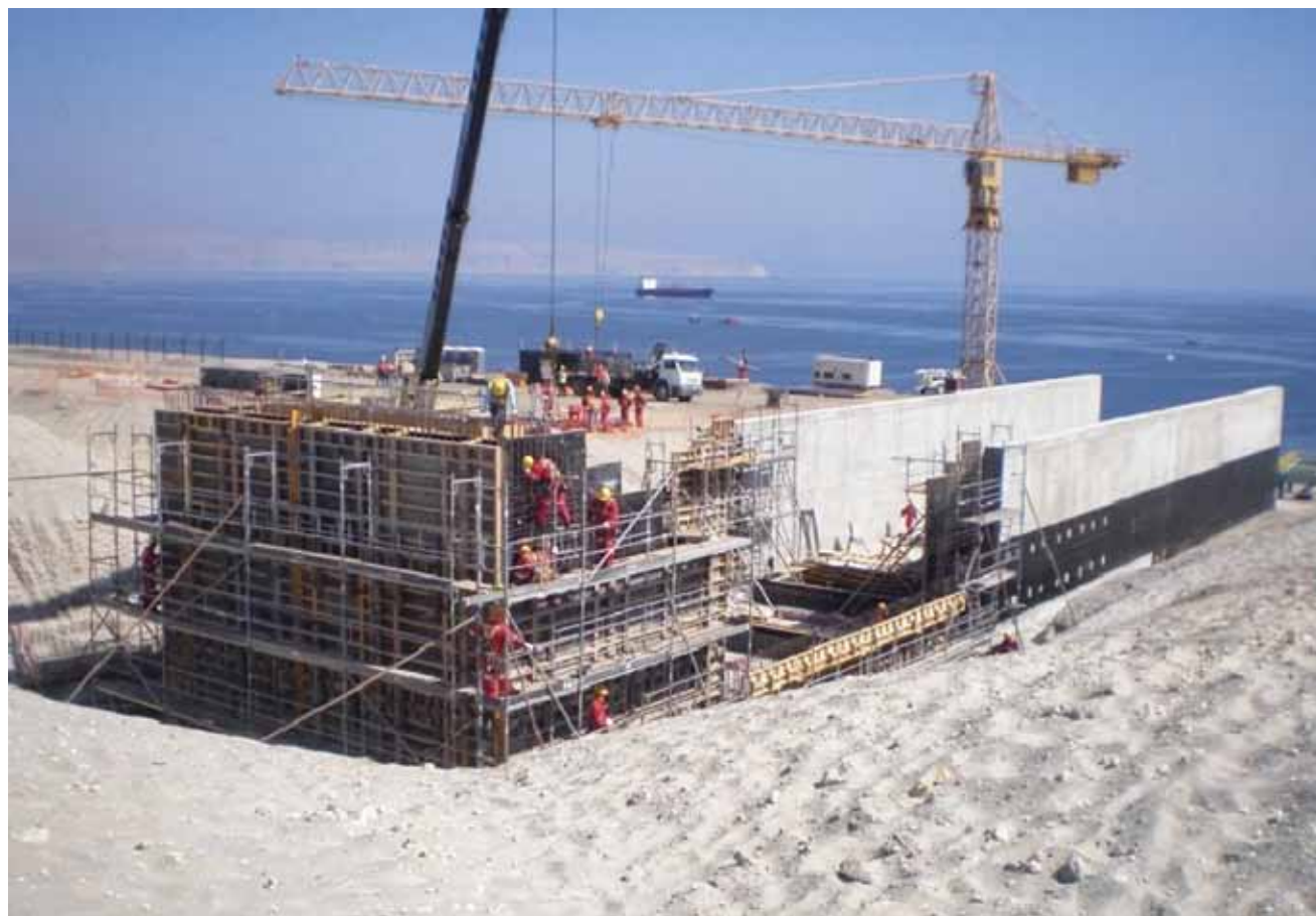
Obras Civiles Terminal GNL Mejillones, Antofagasta - Chile
