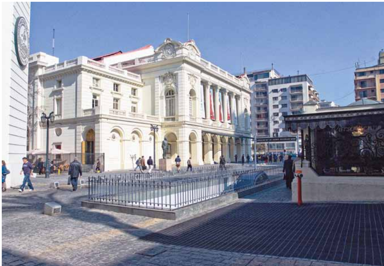
Estacionamiento Subterráneo Plaza Mekis, Santiago - Chile
