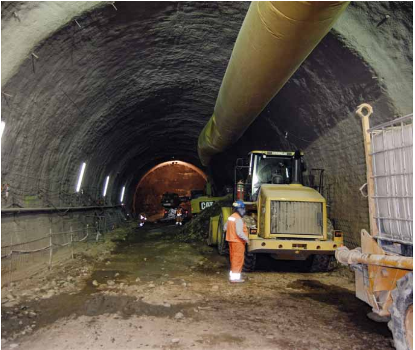
Pique Marathon, Tramo 3 Línea 6 Metro de Santiago, Santiago - Chile
