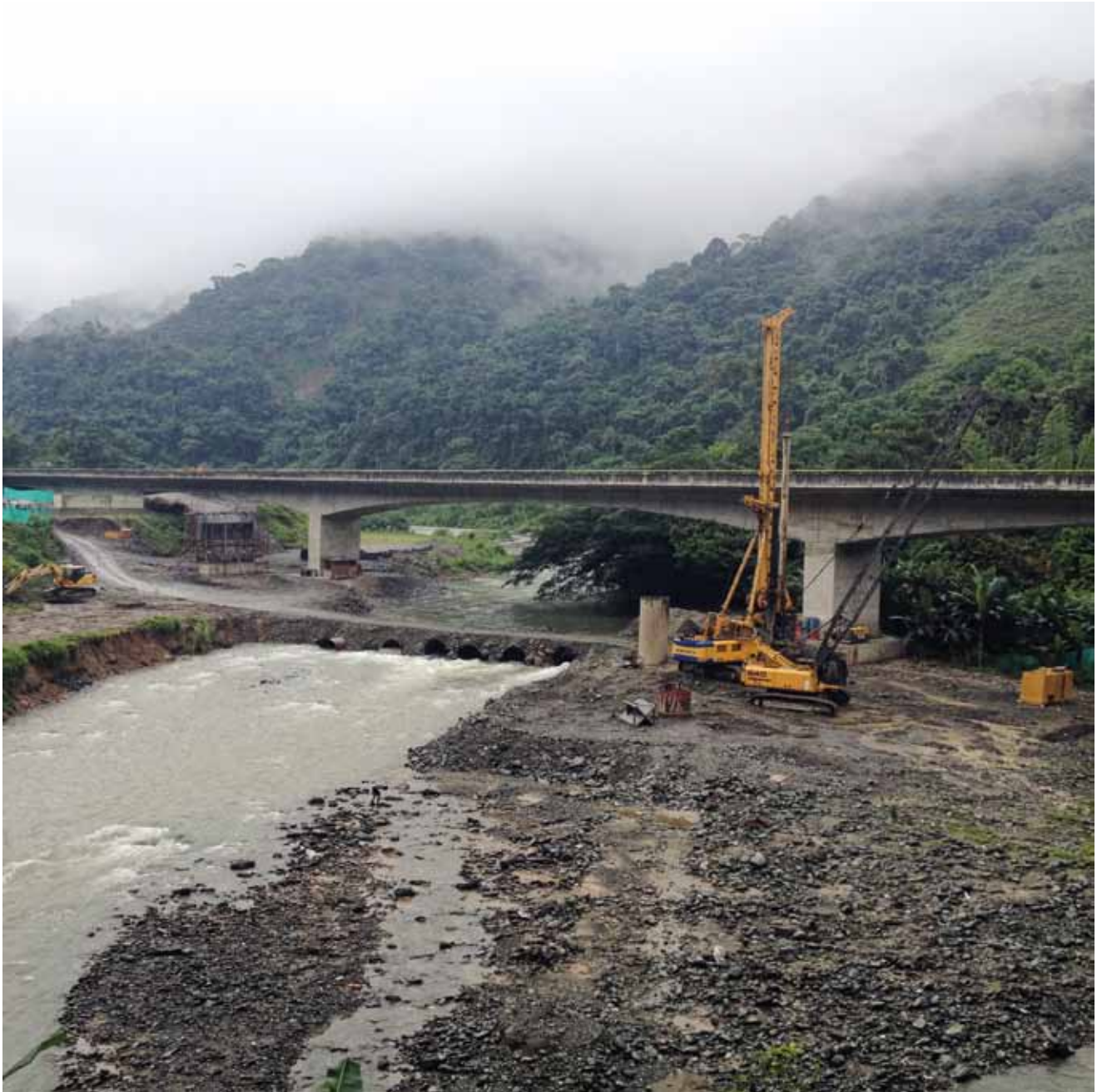
Pilotes Viaducto Carretera Buga Buenaventura, Colombia
