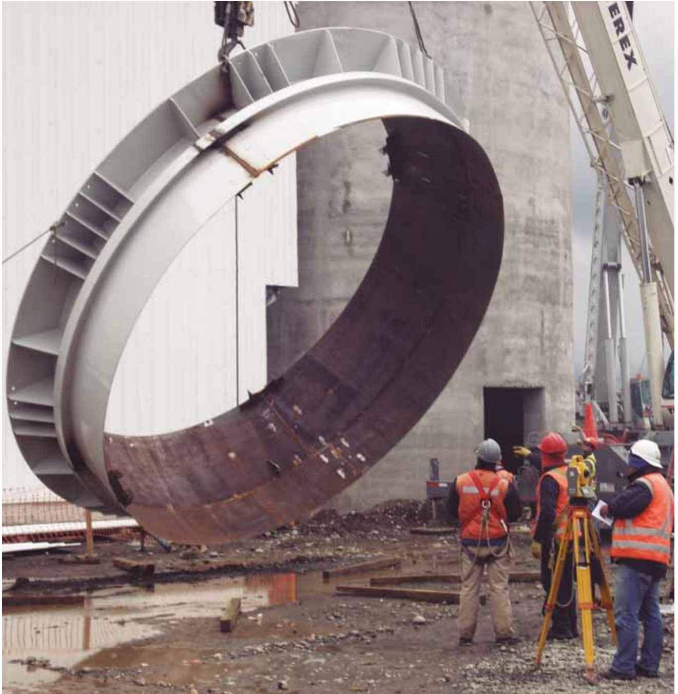
Planta de Cementos Trapén Lafarge, Puerto Montt - Chile
