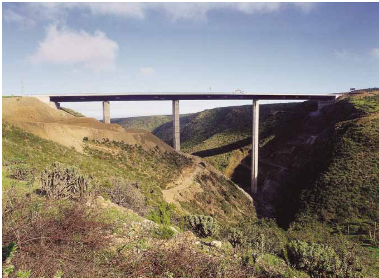
Empujado y Postensado Losa Puente Amolanas, Coquimbo - Chile
