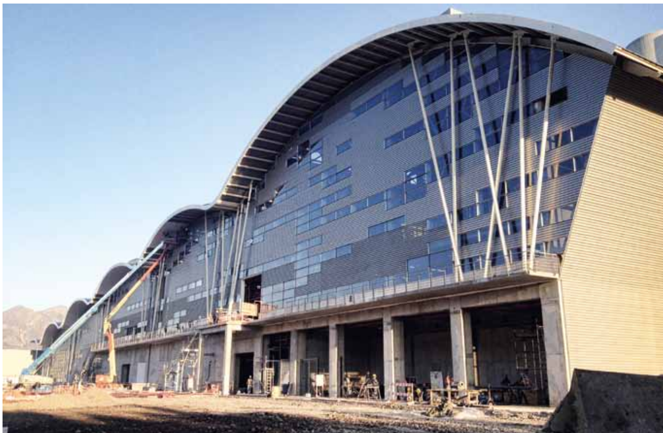
Construcción y Montaje Horno F y Ampliación Planta Llay Llay de Cristalería Chile, Llay Llay - Chile
