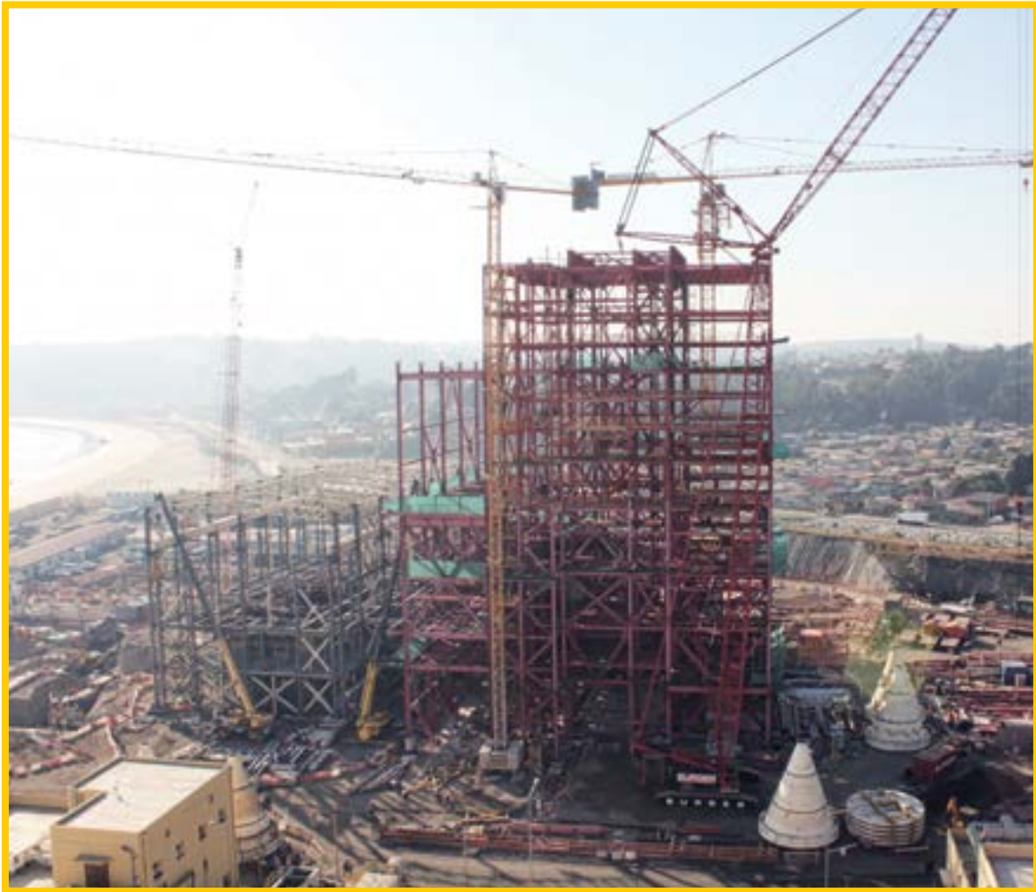
Montaje Electromecánico Caldera Poder, Unidad 4 [Campiche 240 MW Coal Fired Power Project], Ventanas - Chile
