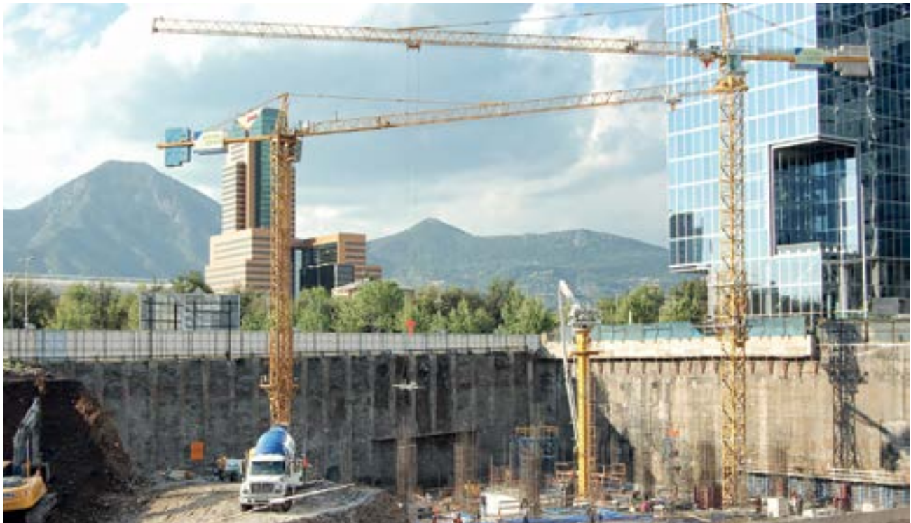
Excavaciones para el edificio de oficinas Arrau, Av. Presidente Riesco 5561, Las Condes, Santiago - Chile
