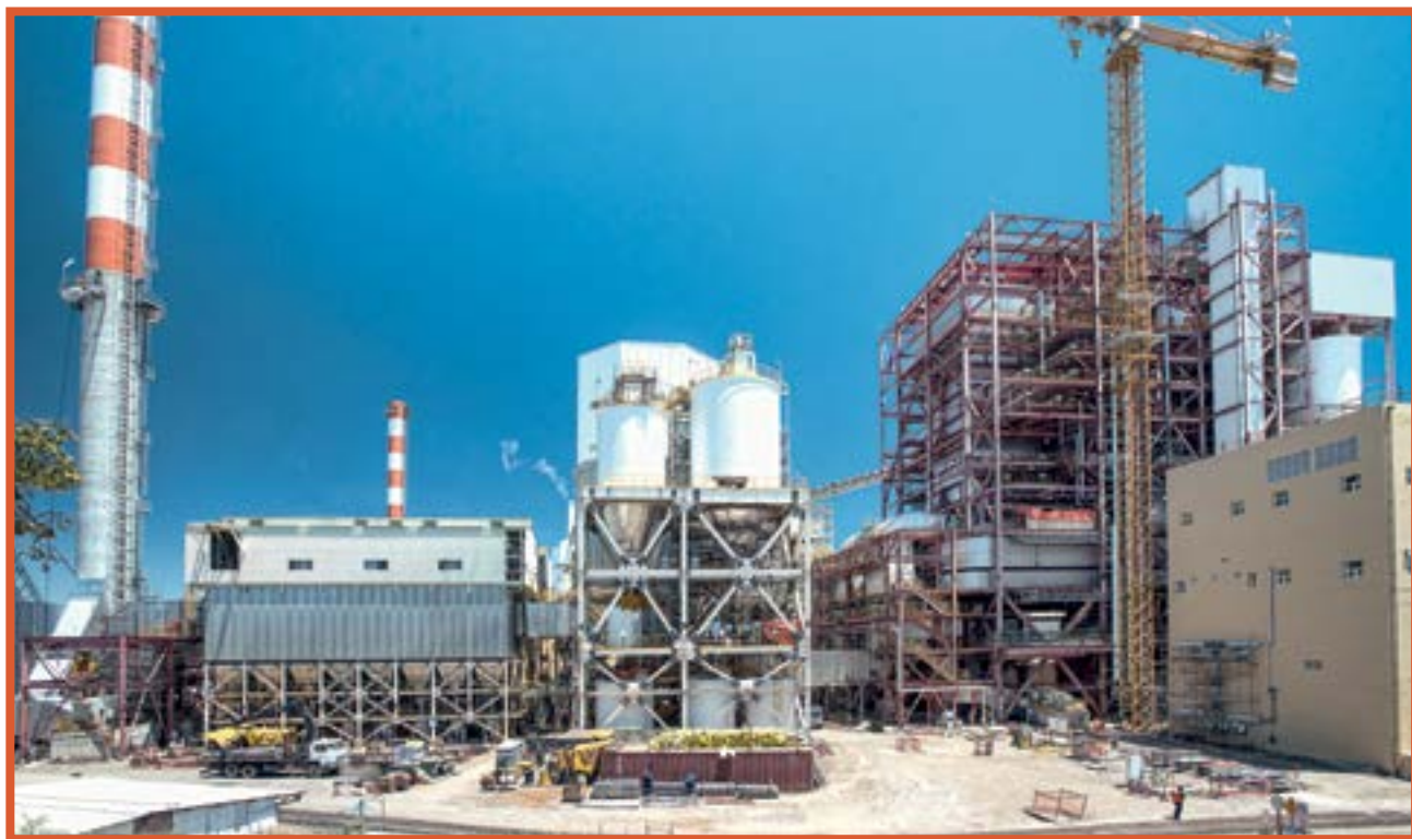
Campiche 240 MW Coal Fired Power Project At Nueva Ventanas, Chile. Montaje Electromecánico Caldera Poder, Fabric Filter, FGD, SDA.
