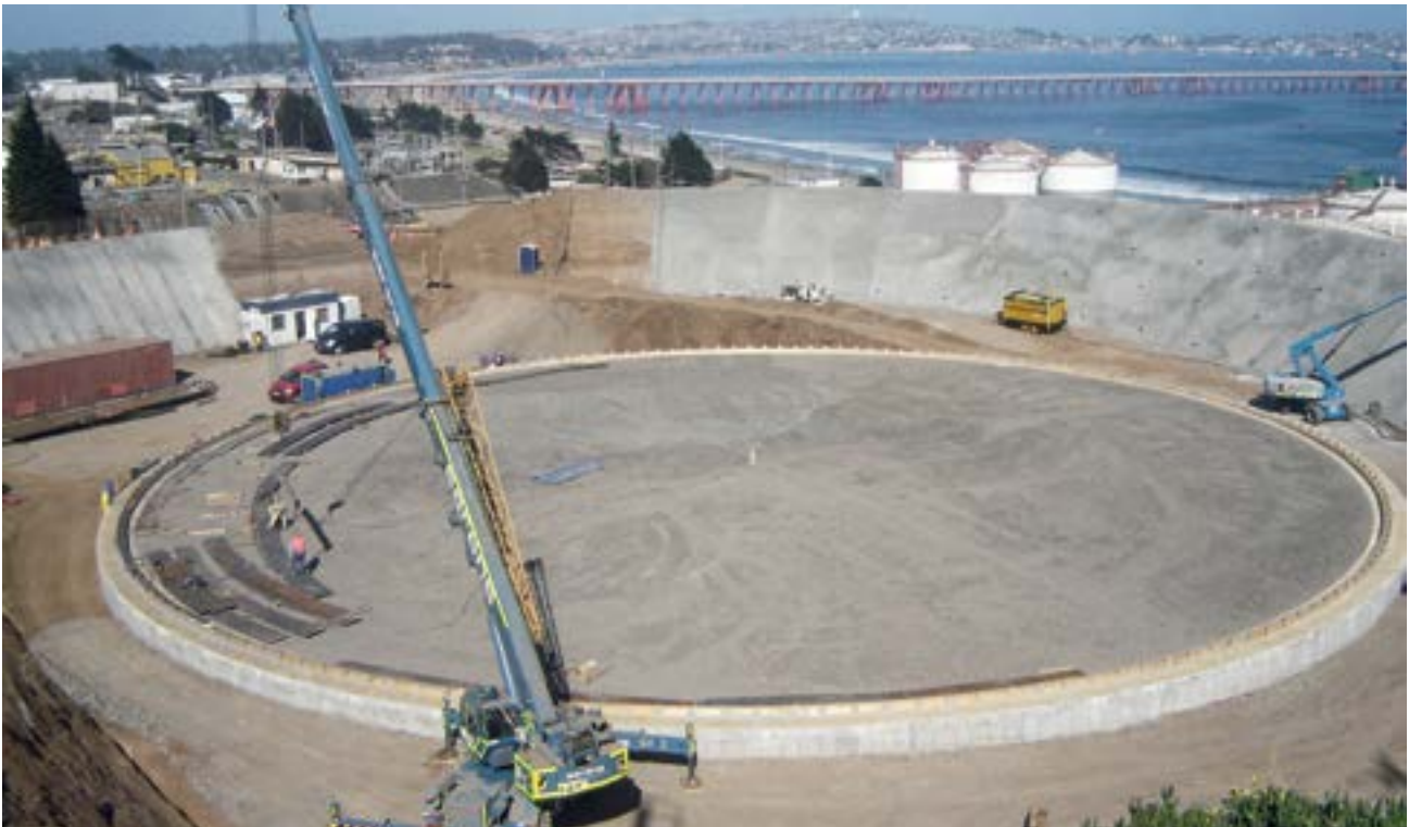
Planta de LPG Refrigerado, Oxiquim Lipigas, Quintero - Chile
