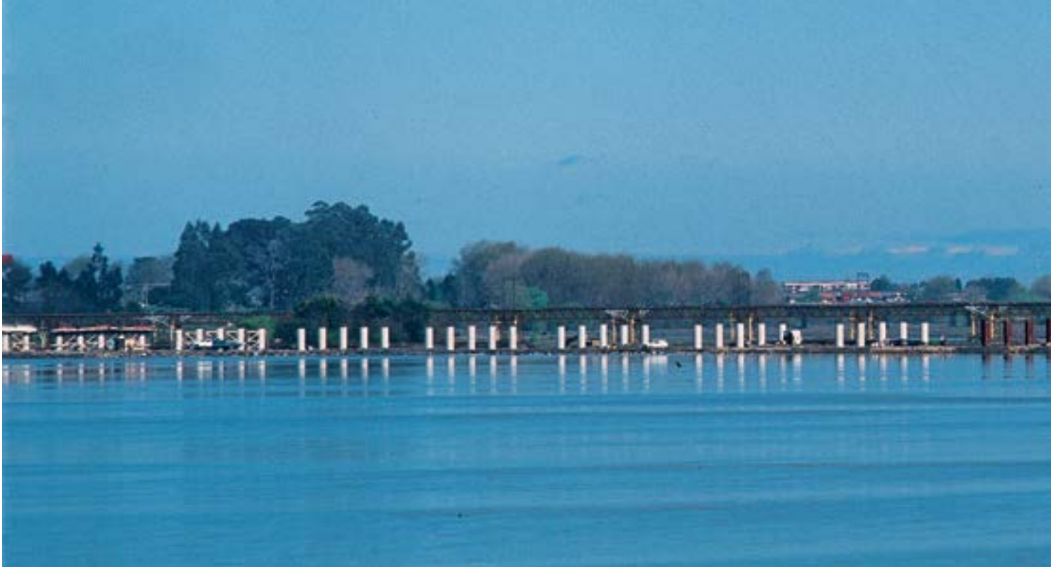
Pilotes puente Llacolén Río Bío-Bío, Octava Región - Chile
