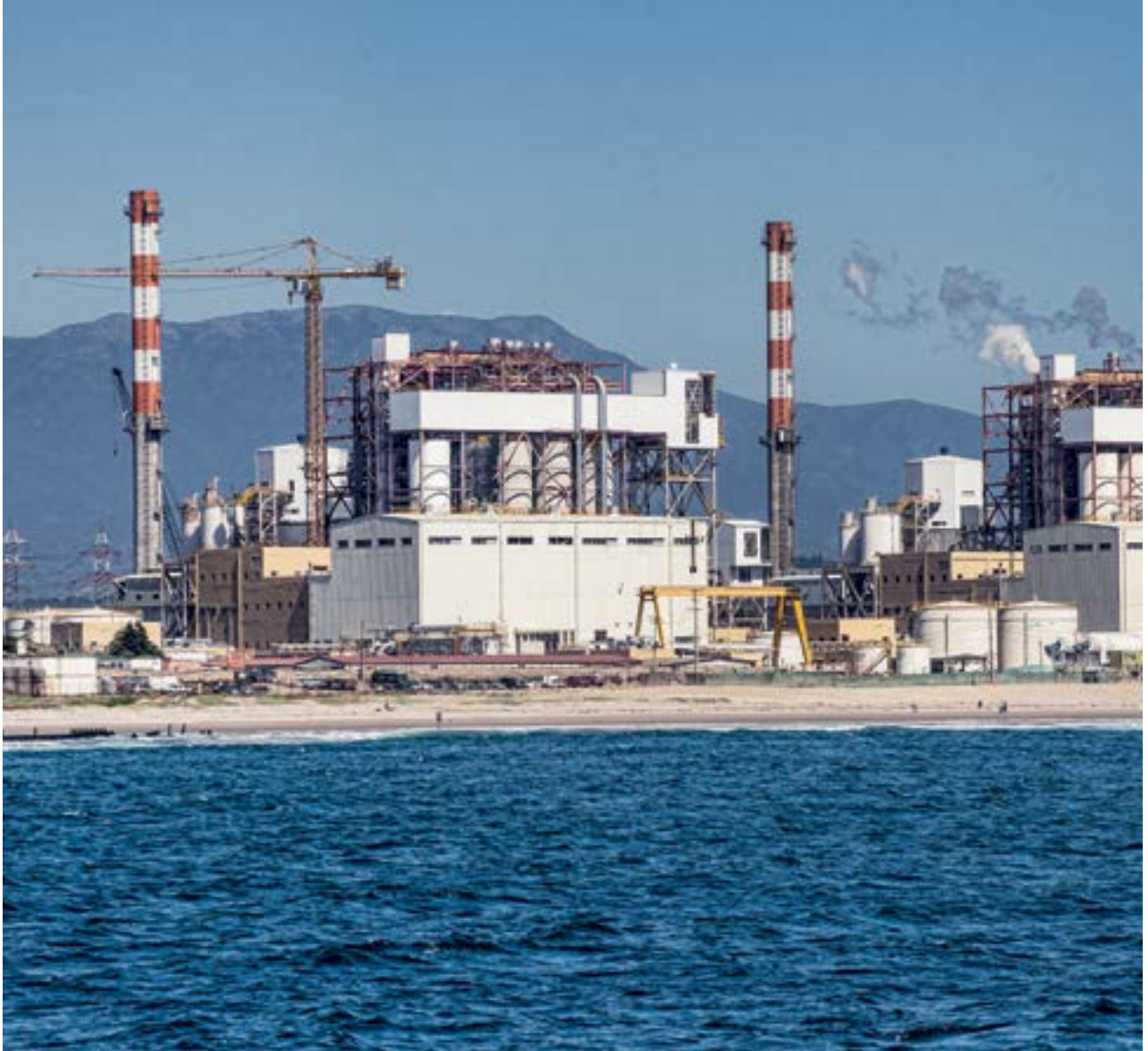
Nueva Ventanas 240 MW Coal Fired Power Project, Central Nueva Ventanas , Posco, Ventanas - Chile
