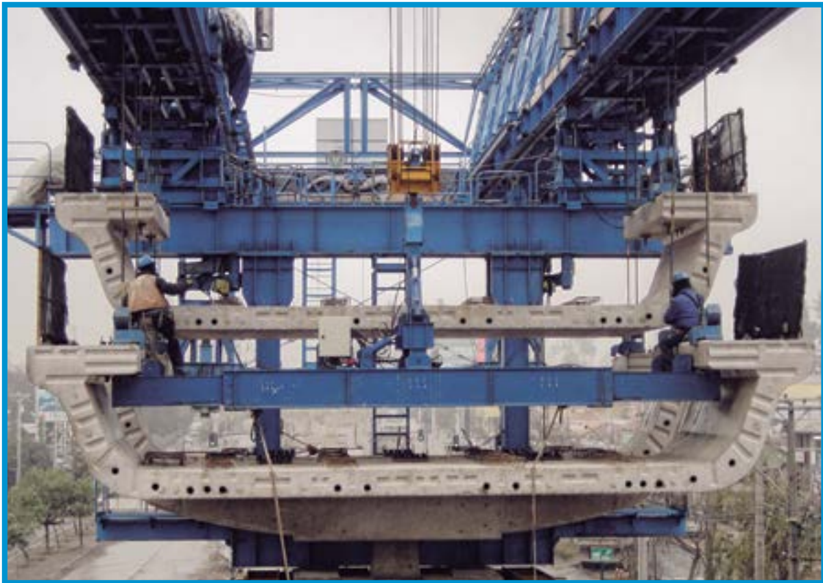
Viaducto Línea 4 Metro de Santiago, Santiago - Chile
