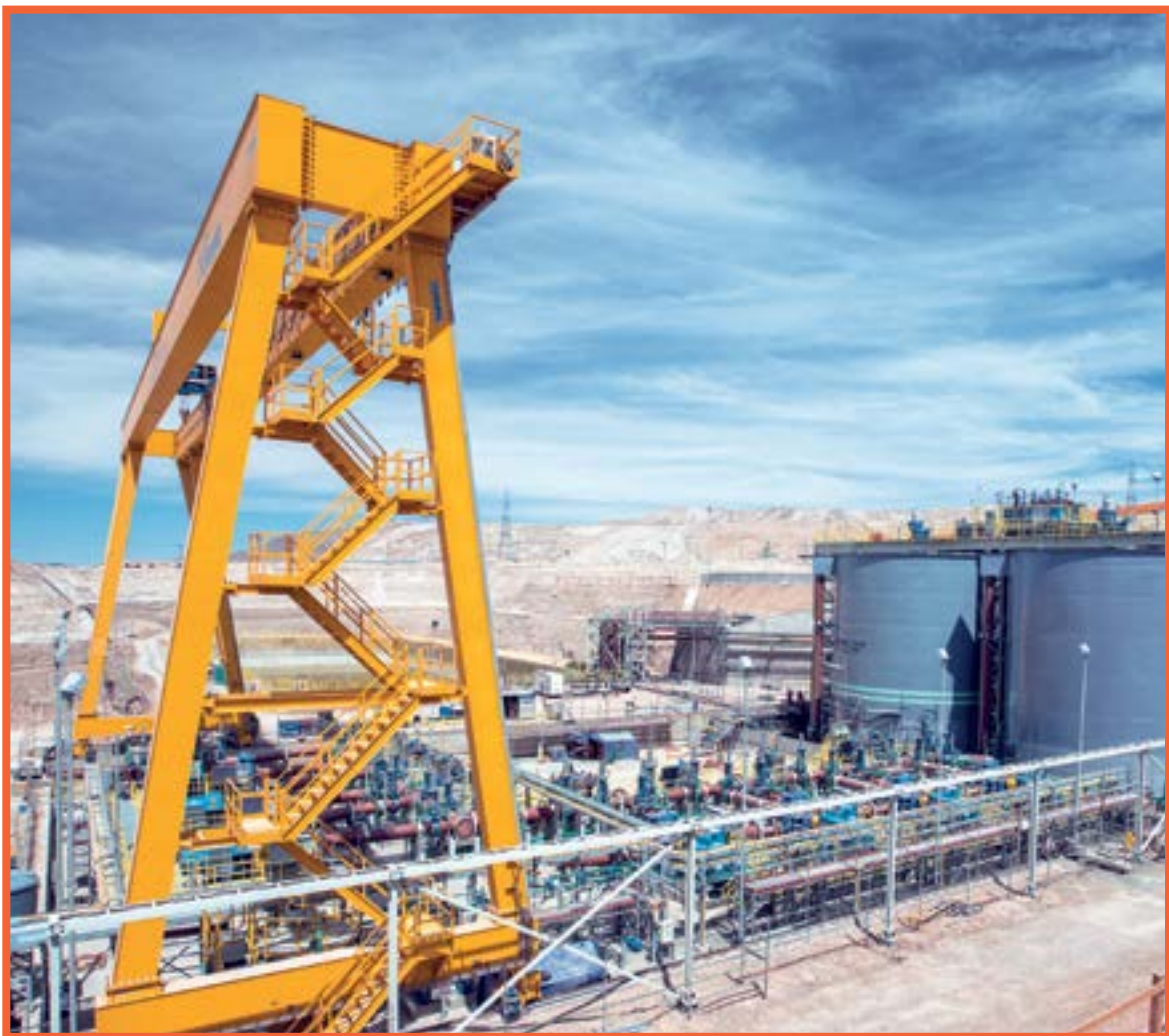
Obras Civiles y Montaje Electromecánico Área de Espesamiento y Relaves Codelco Ministro Hales, Calama - Chile
