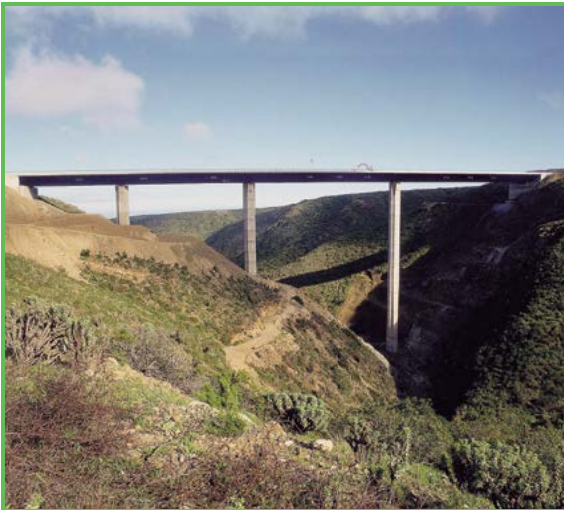
Empujado y Postensado Losa Puente Amolanas, Coquimbo - Chile
