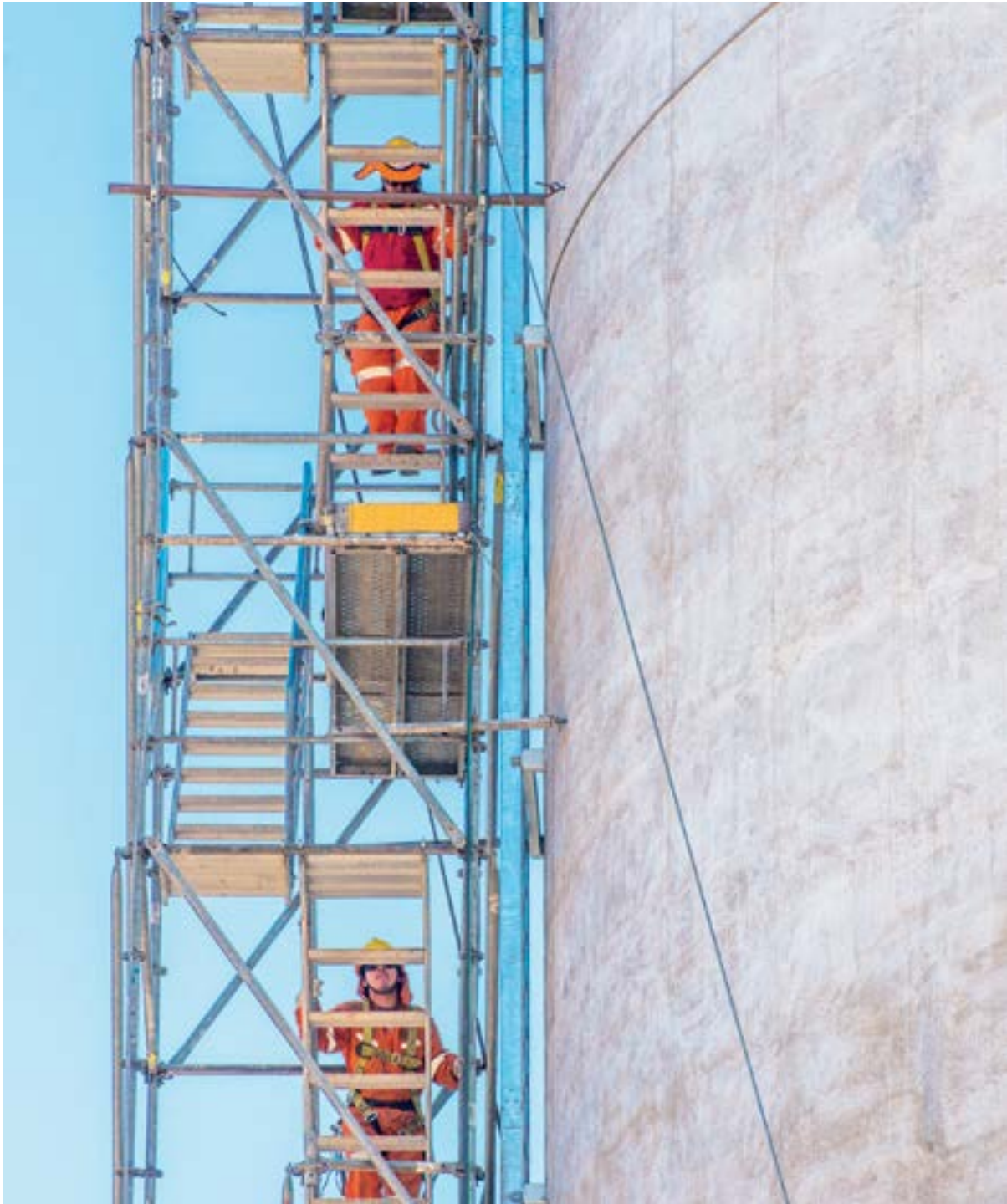
Colaboradores construcción Silo de Almacenamiento. Obras Civiles y Montaje Electromecánico ampliación Planta Pellets, Huasco - Chile
