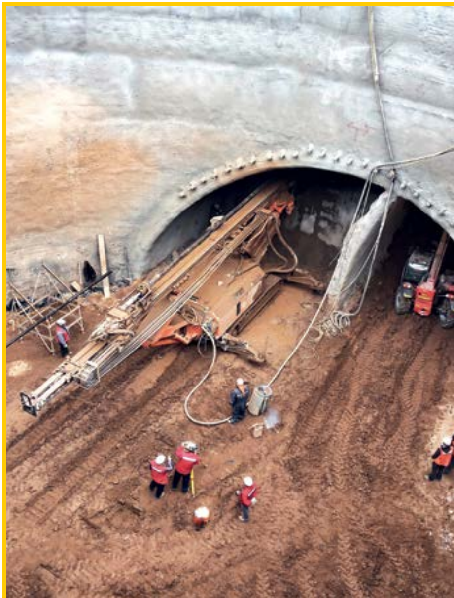
Micropilotes Estación Bio Bio – Línea 6 Metro de Santiago - Chile
