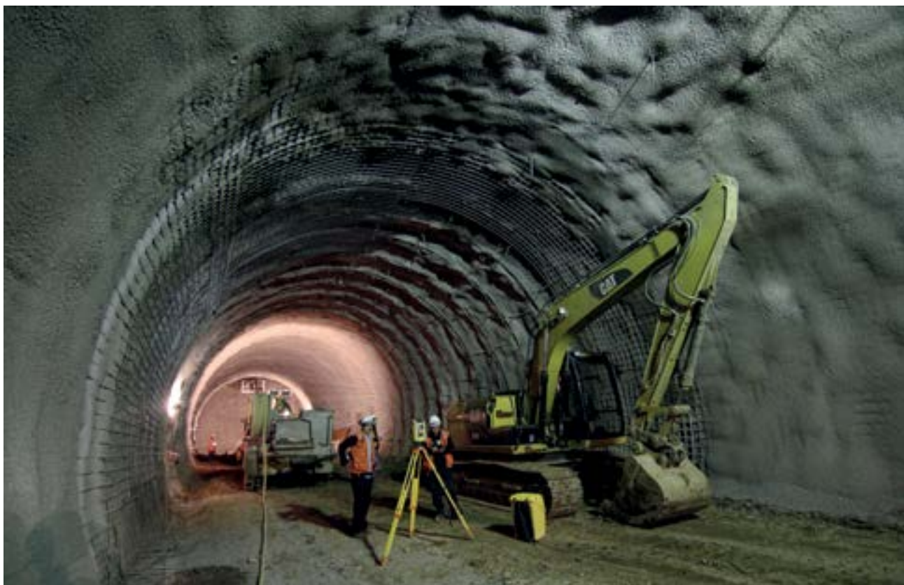
Obras civiles de piques, galerías y túneles Tramo 4 - Línea 6, Metro de Santiago – Chile
