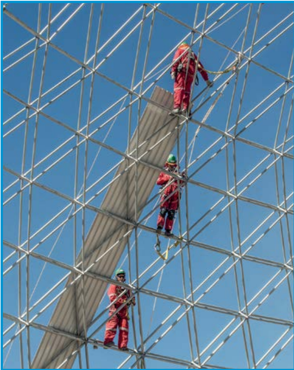
Colaboradores Proyecto Línea de Chancado 2° y 3° 20 Ktpd, Minera Centinela, Región de Antofagasta - Chile
