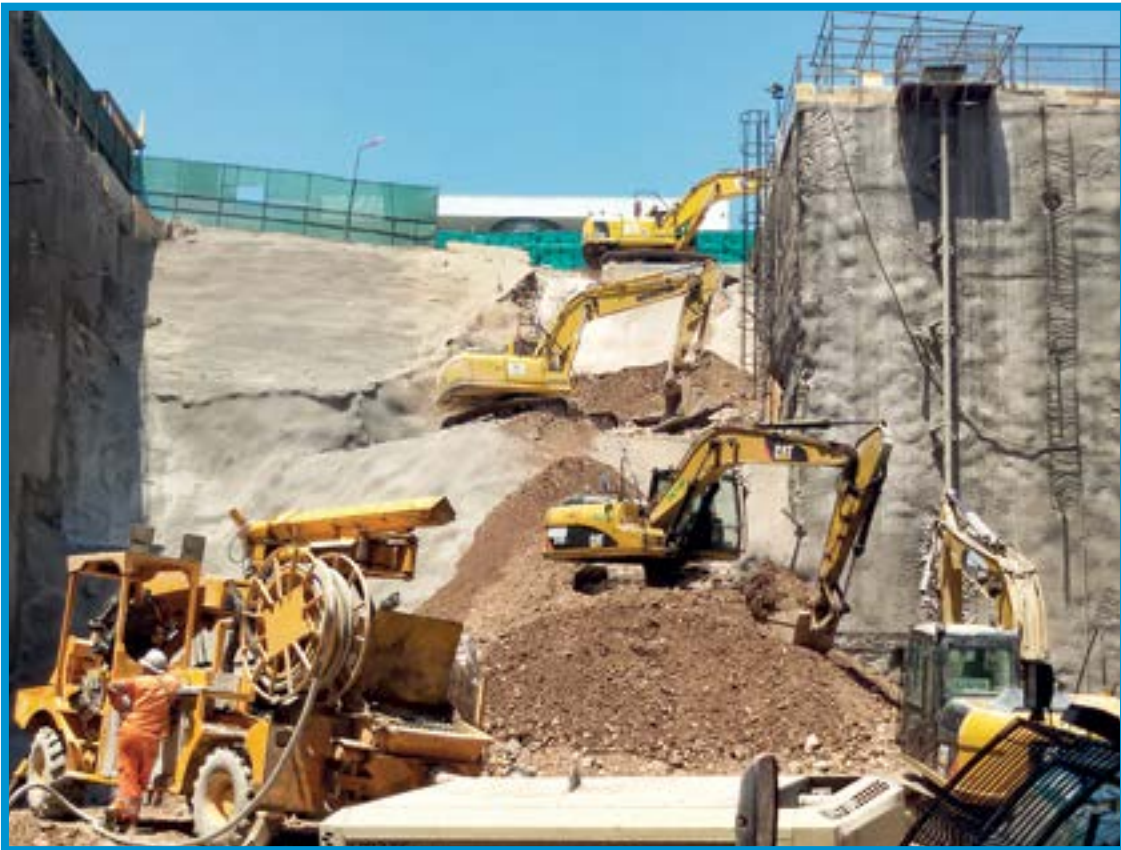
Obras civiles de piques, galerías y túneles Tramo 3 - Línea 6, Metro de Santiago – Chile. Pique Estación Ñuñoa.
