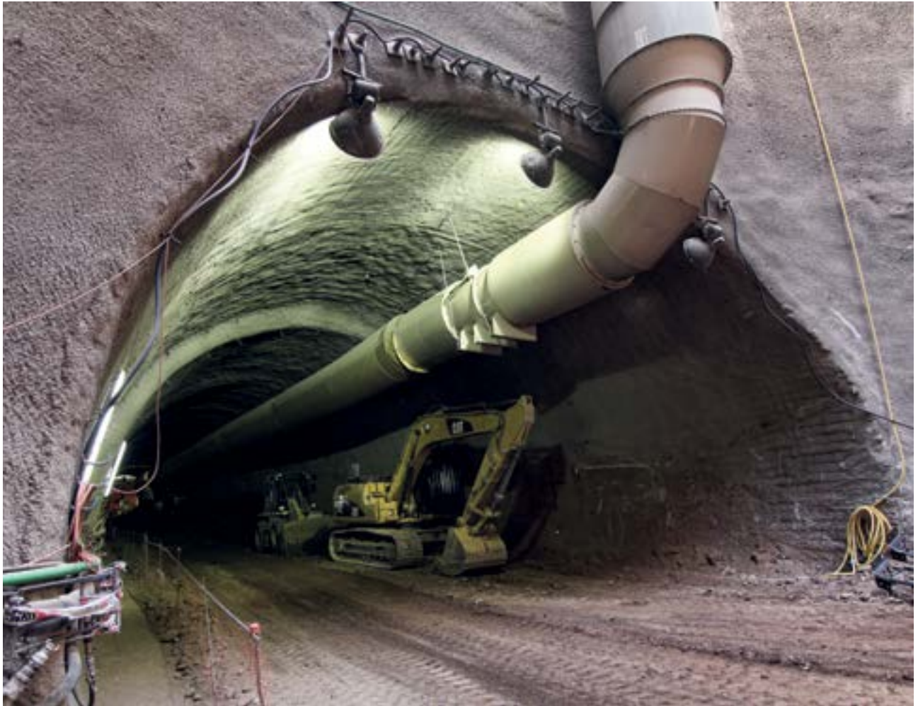
Obras civiles de piques, galerías y túneles Tramo 4 - Línea 6, Metro de Santiago – Chile
