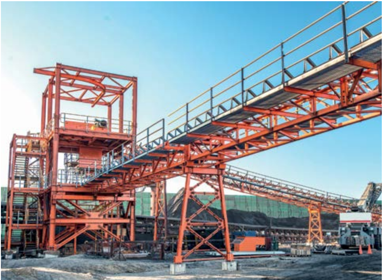
Obras Civiles y Montaje Electromecánico ampliación Planta Pellets, Huasco - Chile. Montaje correas transportadoras y torres de transferencia.
