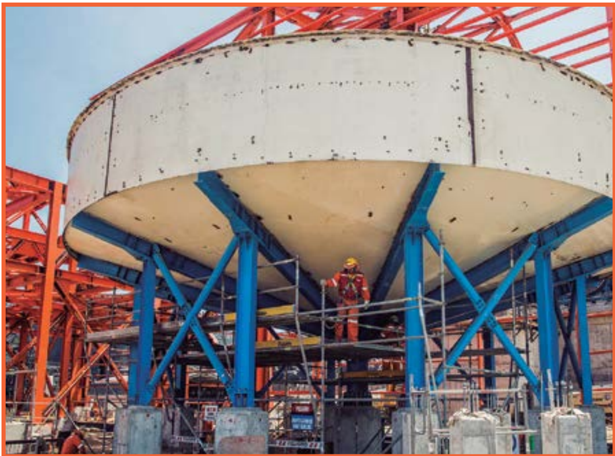
Colaborador proyecto ampliación Planta Pellets, Huasco - Chile
