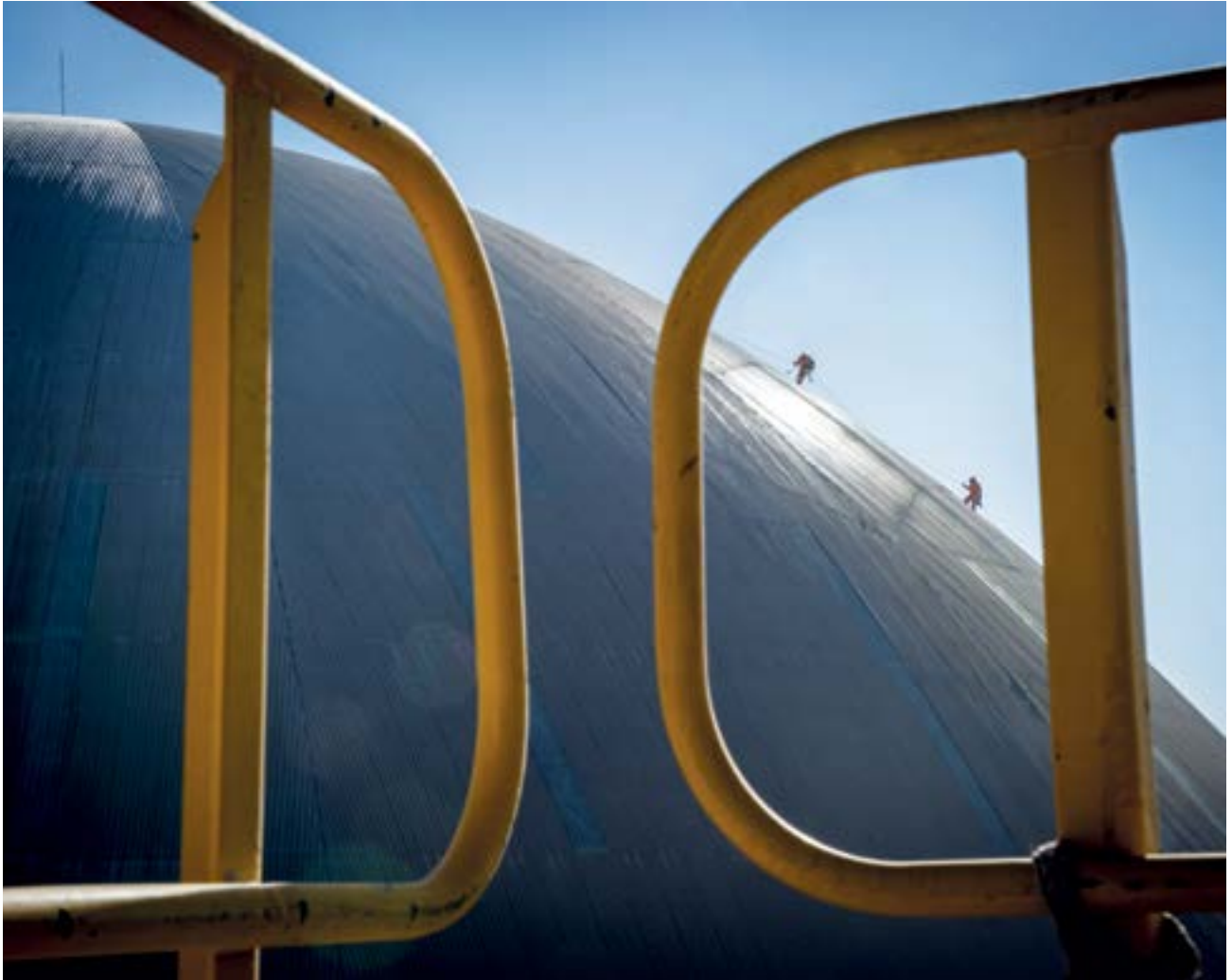
Línea de Chancado secundario y terciario de Minera Centinela para Metso Minerals, Sierra Gorda, Región de Antofagasta - Chile
