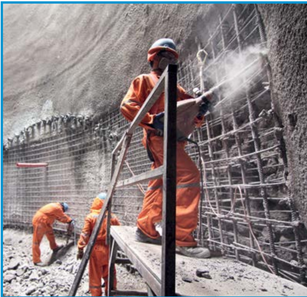
Obras civiles de pique, galería y túnel del enlace Línea 6 -Línea 3, Metro de Santiago - Chile
