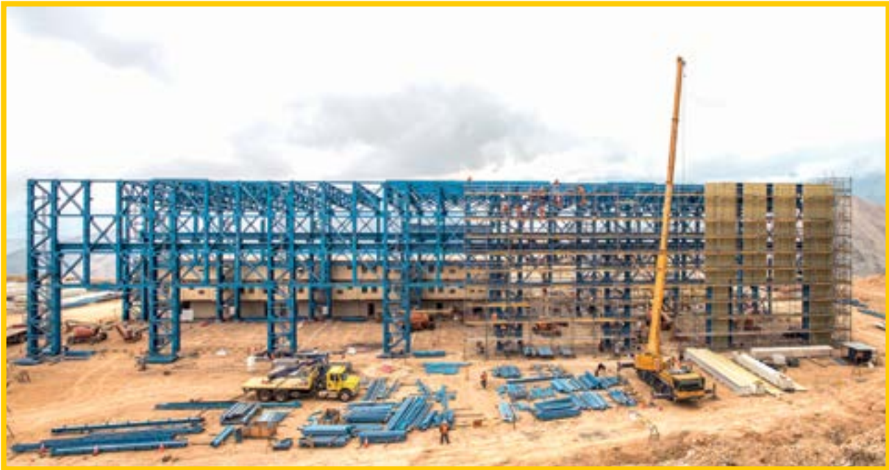
Estructura y Revestimiento Proyecto Rajo Sur, Codelco El Teniente, Rancagua - Chile. Montaje Estructural y Revestimiento Nave Multipropósito.
