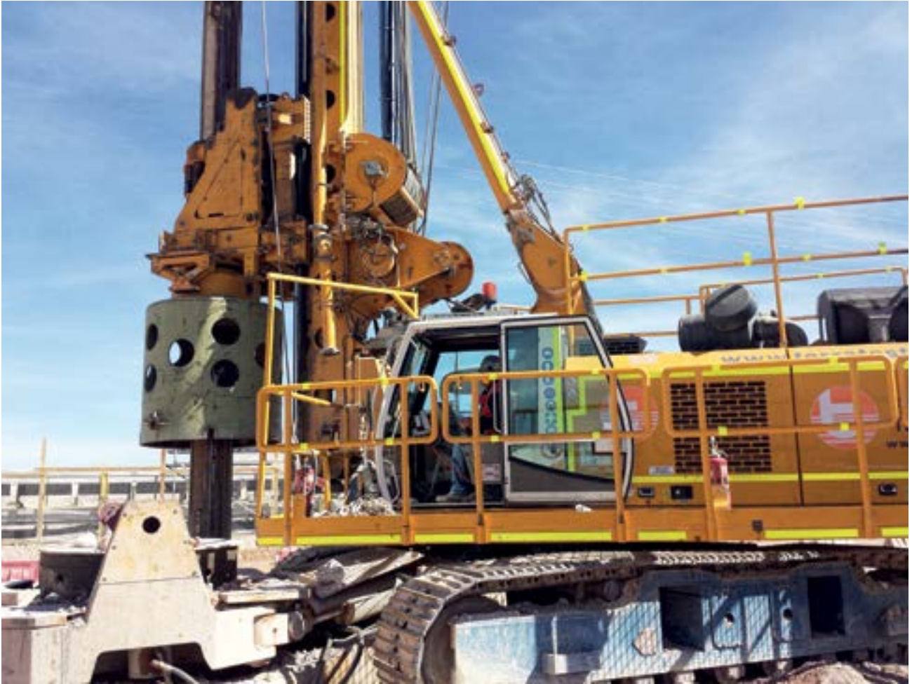
Minera Escondida, Pilotes de gran diámetro, Pilotes Terratest.
