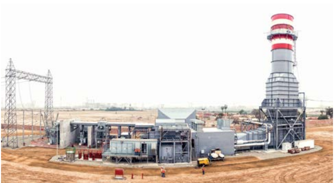
Central de Ciclo Simple, Santo Domingo de los Olleros – Siemens, Perú
