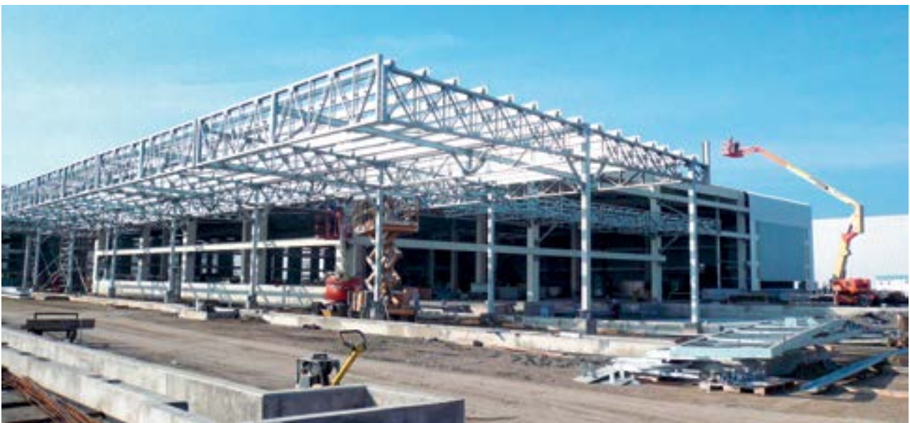
Construcción, obras civiles y arquitectura, fabrica contenedores refrigerados Maersk , San Antonio - Chile
