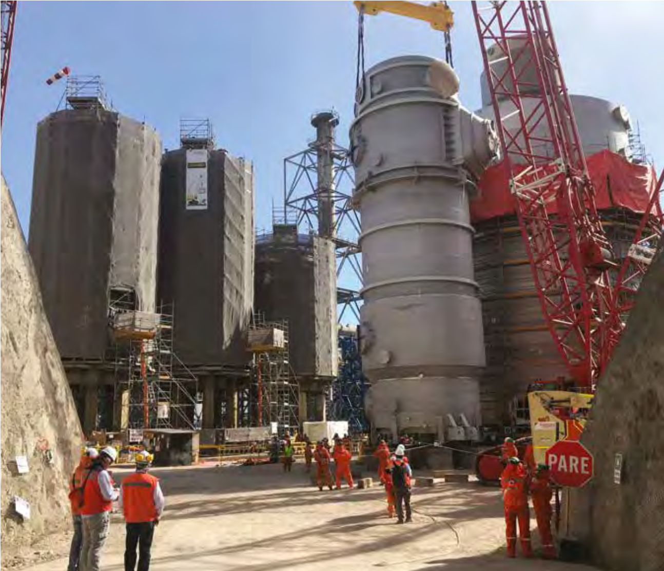
OBRAS CIVILES Y MONTAJE ELECTROMECAÁNICO DE LAS PLANTAS DE ÁCIDO Nº3 Y Nº4, CODELCO, CHUQUICAMATA, CHILE.
