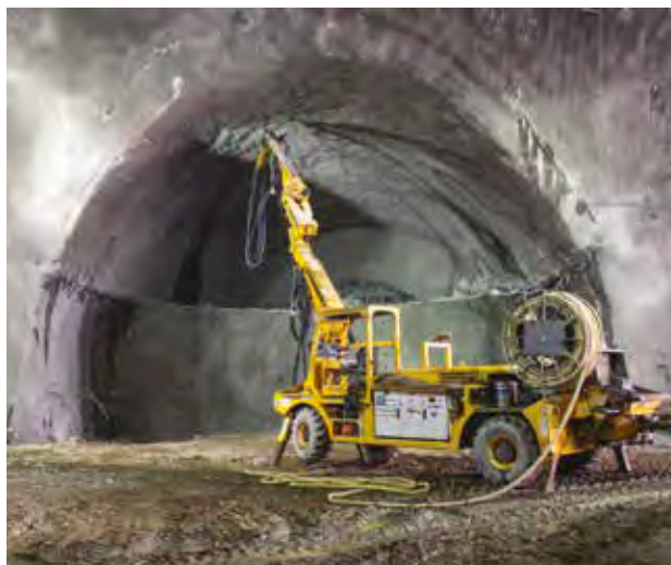
OBRAS CIVILES DE PIQUES, GALERÍAS Y TÚNELES DE TRAMOS 2 Y 3 NORTE DE LÍNEA 3 DE METRO DE SANTIAGO – CHILE
