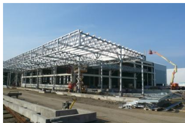
Fábrica de contenedores refrigerados - Maersk
