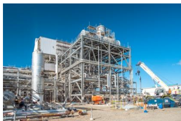
Desmontaje tren N°3 Planta Metanol
