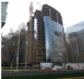
Edificio Nueva Las Condes 7
