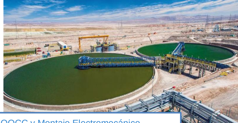
OOCC y Montaje Electromecánico Espesamiento y relaves Ministro Hales
