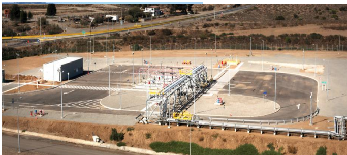
Construcción Patio Carga de Camiones GNL – Quinteros GNL Quintero
