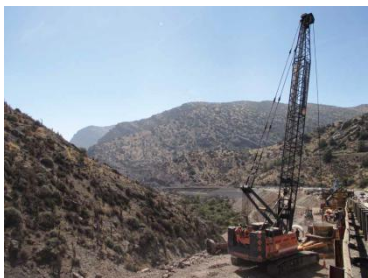
Pilotes Viaducto Las Chilcas, Ruta 5 Norte
