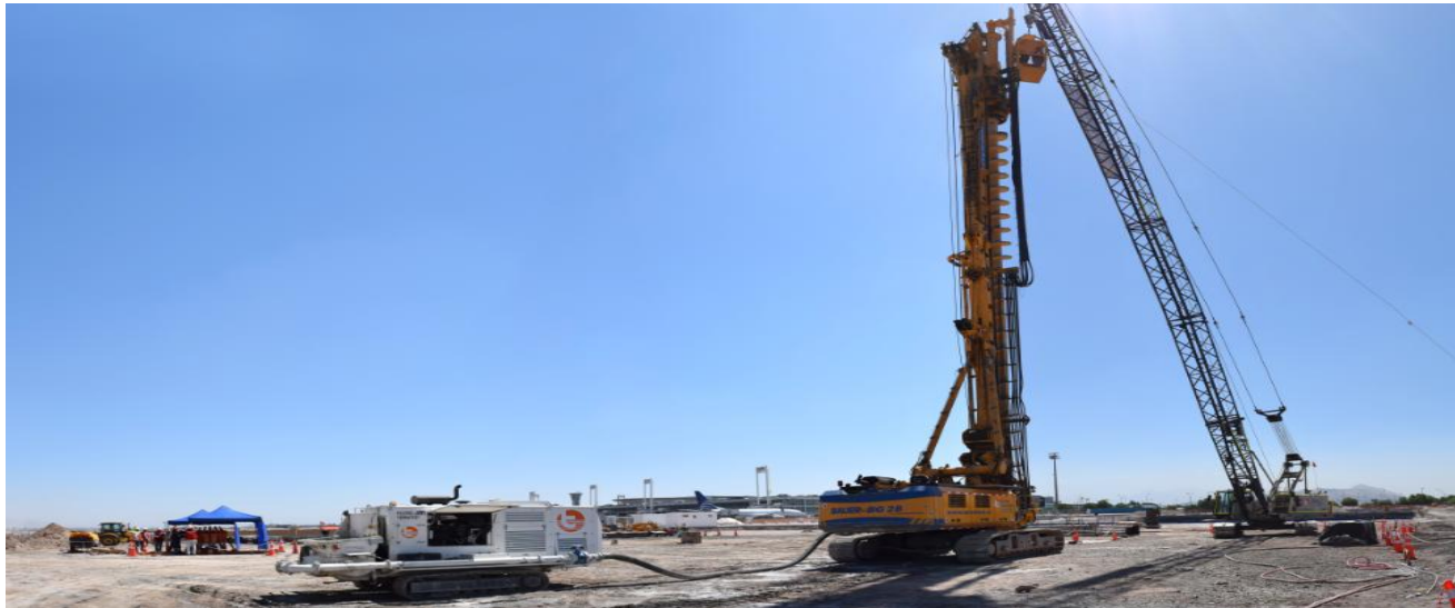
Pilotes CFA, Bajo lodos y ensayos de carga en ampliación Aeropuerto Arturo Merino Benítez
