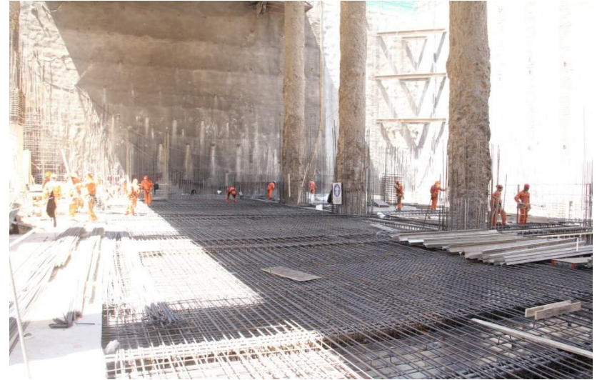
Obras civiles Los Leones Norte del Metro de Santiago.
