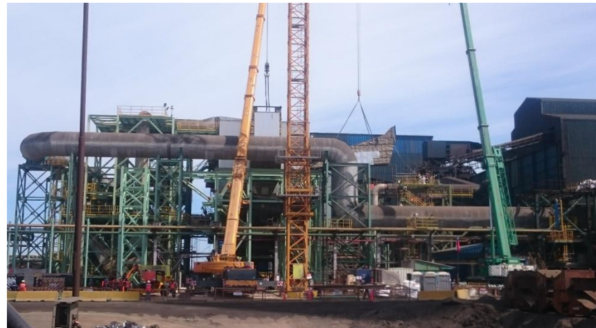
Implementación Sistema de Captación Gases Secundarios CT - CODELCO Ventanas
