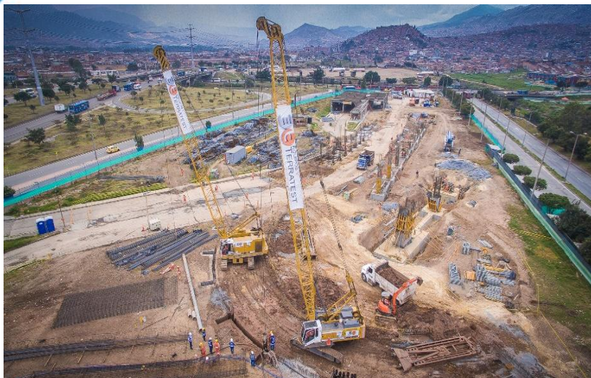
Cimentaciones TransMiCable - Estación El Tunal. Bogotá, Colombia.
