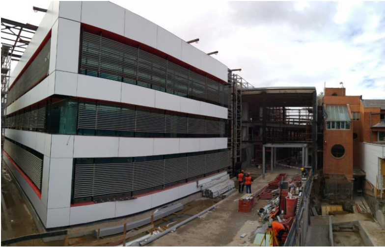
Obras de Instituto Teletón. Santiago, Chile.
