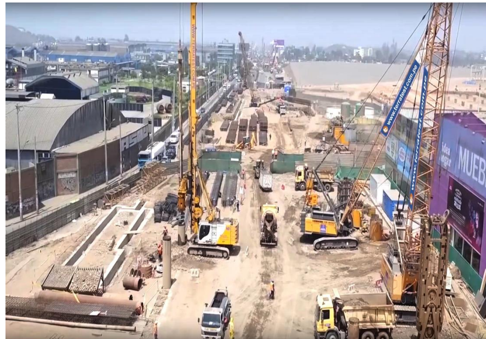
Muros pantalla y Pilotes Metro de Lima (Línea 2). Perú, Lima
