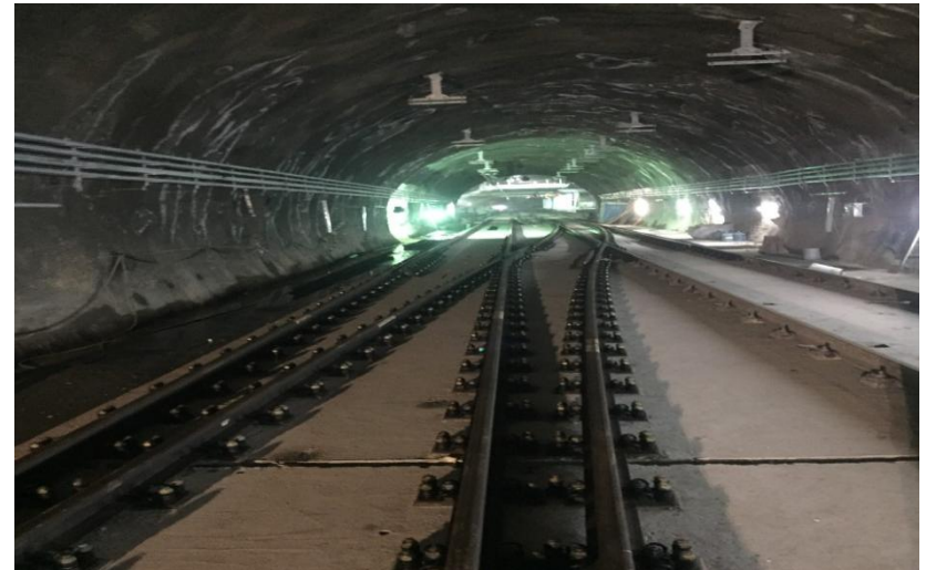
Túnel Interestación Los Leones. Metro de Santiago.
