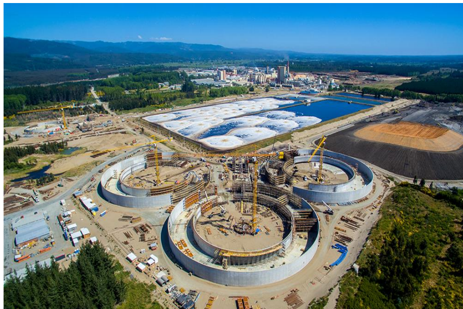
Obras civiles y Montaje electromecánico Planta tratamiento de Efluentes de Celulosa Arauco, Planta Horcones.
