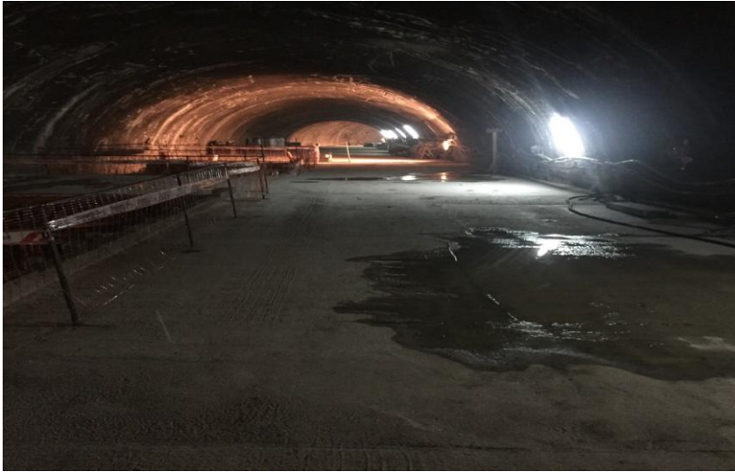
Túnel de conexión L6 – L1 del Metro de Santiago.
