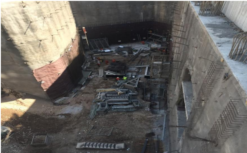
Obras Civiles Los Leones Sur del Metro de Santiago.
