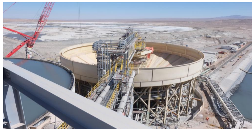
Montaje electromecánico Espesador de Pasta en Mina Centinela, Antofagasta Minerals.
