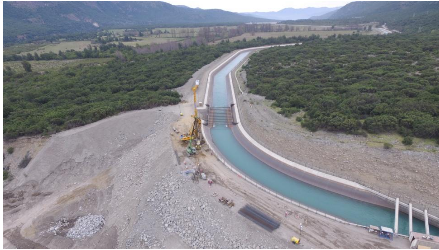
Pantalla temporal de pilotes para reparación Central Hidroeléctrica VI Región
