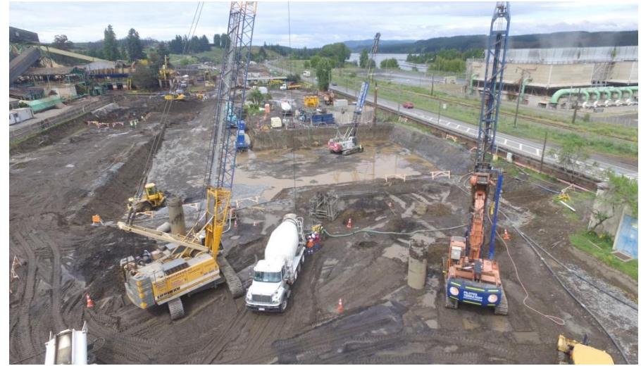
Pilotes de fundación y columnas de grava. Modernización Planta Laja CMPC Fase 2
