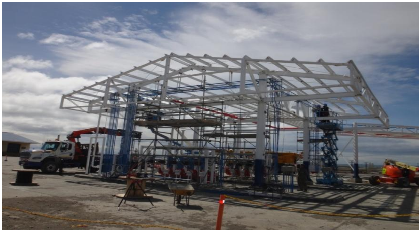
Isla de Carga de Cabo negro ENAP Magallanes – Obras y Montajes
