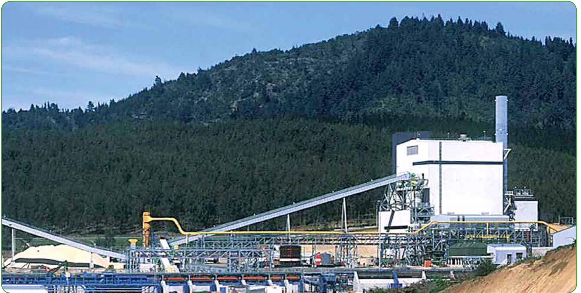
Montaje electromecánico de caldera poder, turbogenerador, galpón de corteza, obras civiles, entre otros.
