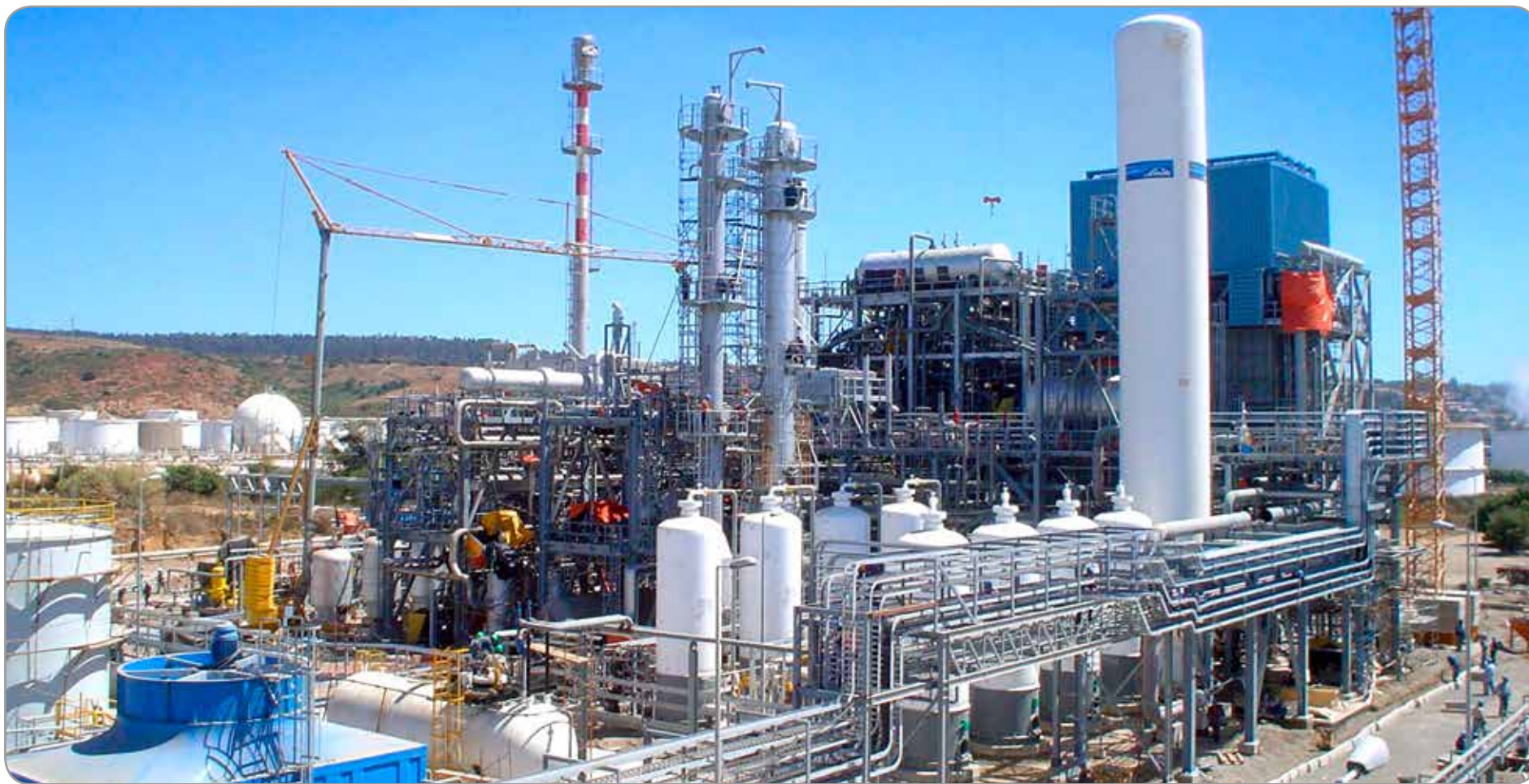
Obras Civiles y montaje electromecánico Planta Hidrógeno
