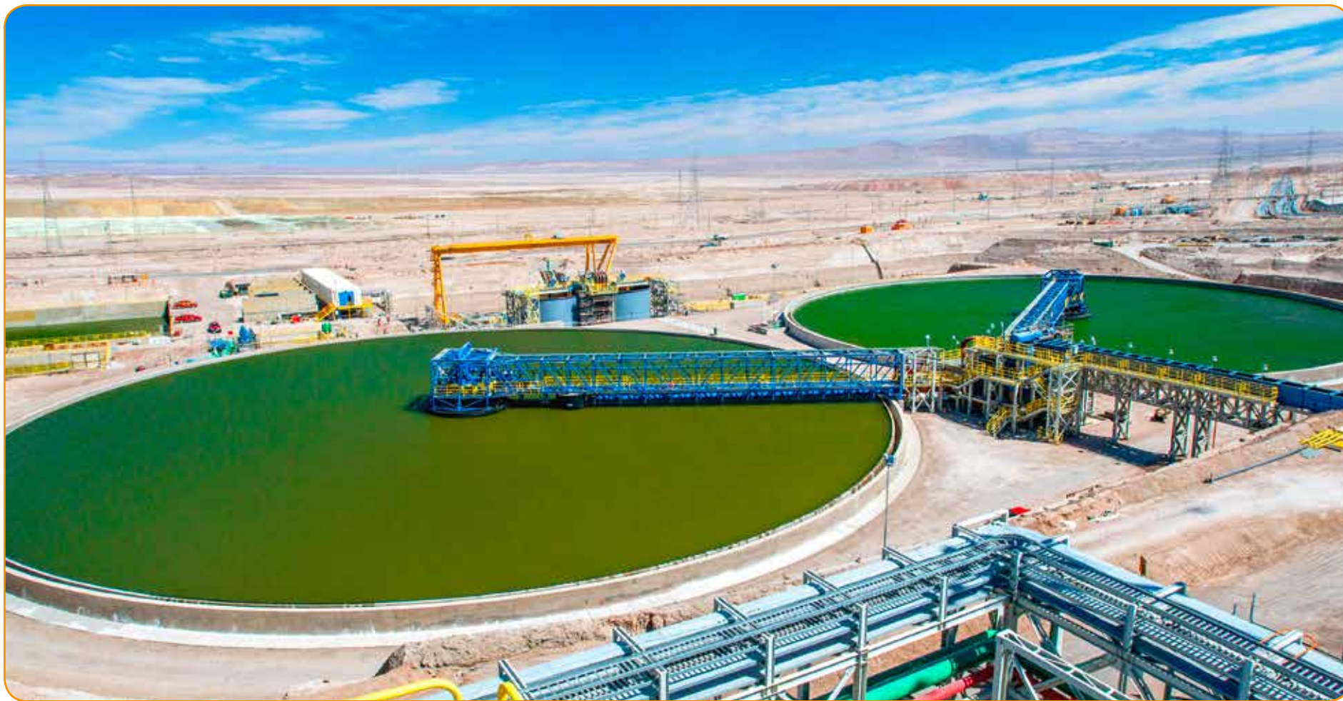
Construcción espesadores de relaves, Codelco - Ministro Hales
