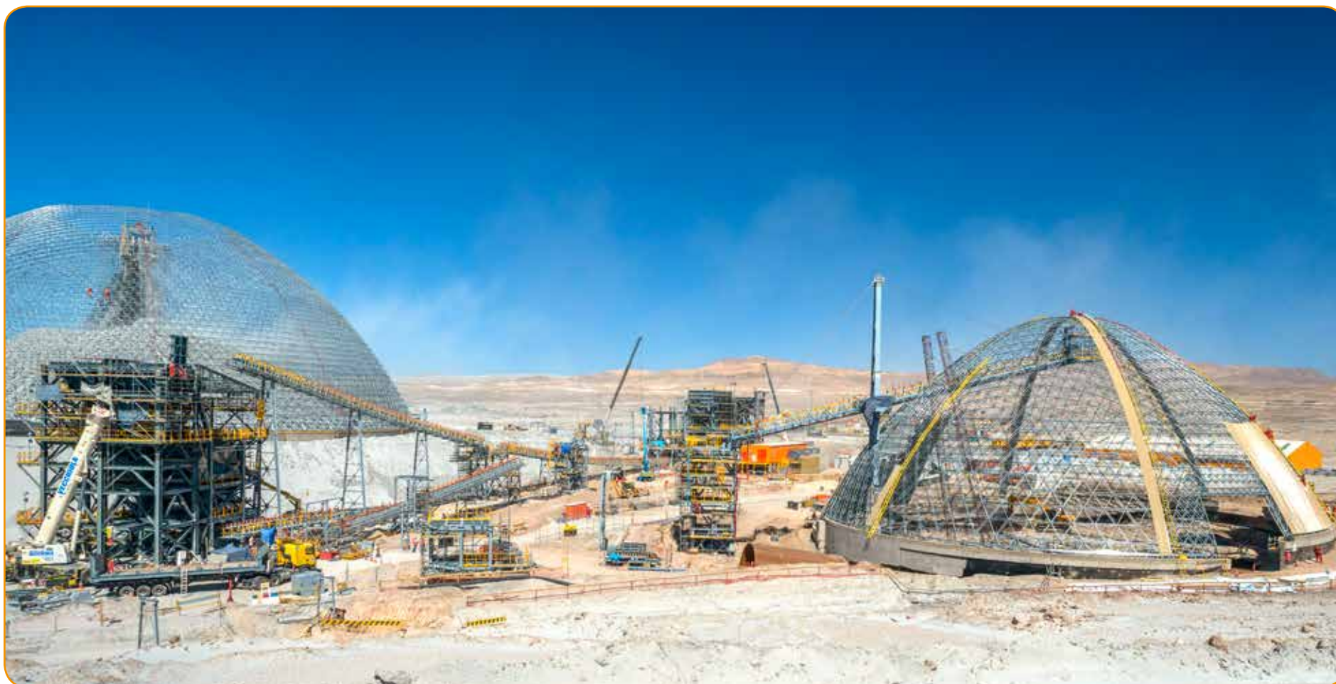
Construcción y montaje, harnero, chancador, correas transportadoras y domo
