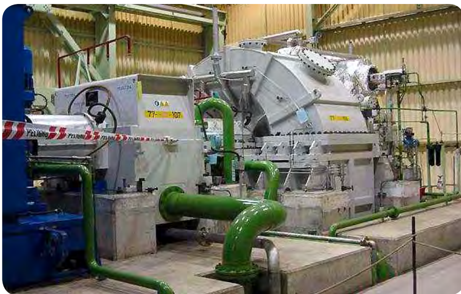
Montaje Turbogenerador 40 MW, CMPC Planta Pacífico
