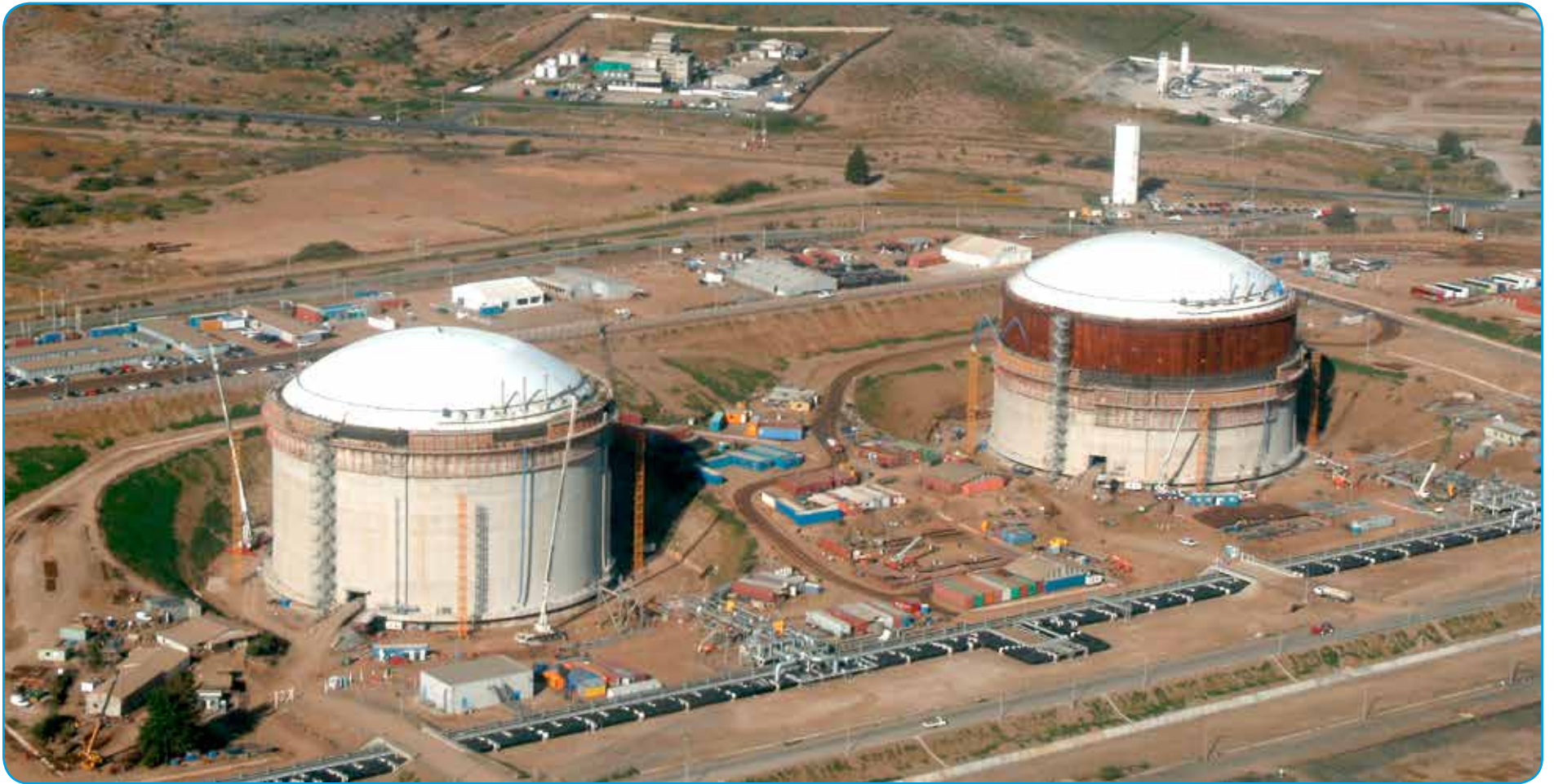
Obras Civiles de 2 estanques de almacenamiento de GNL - Quintero
