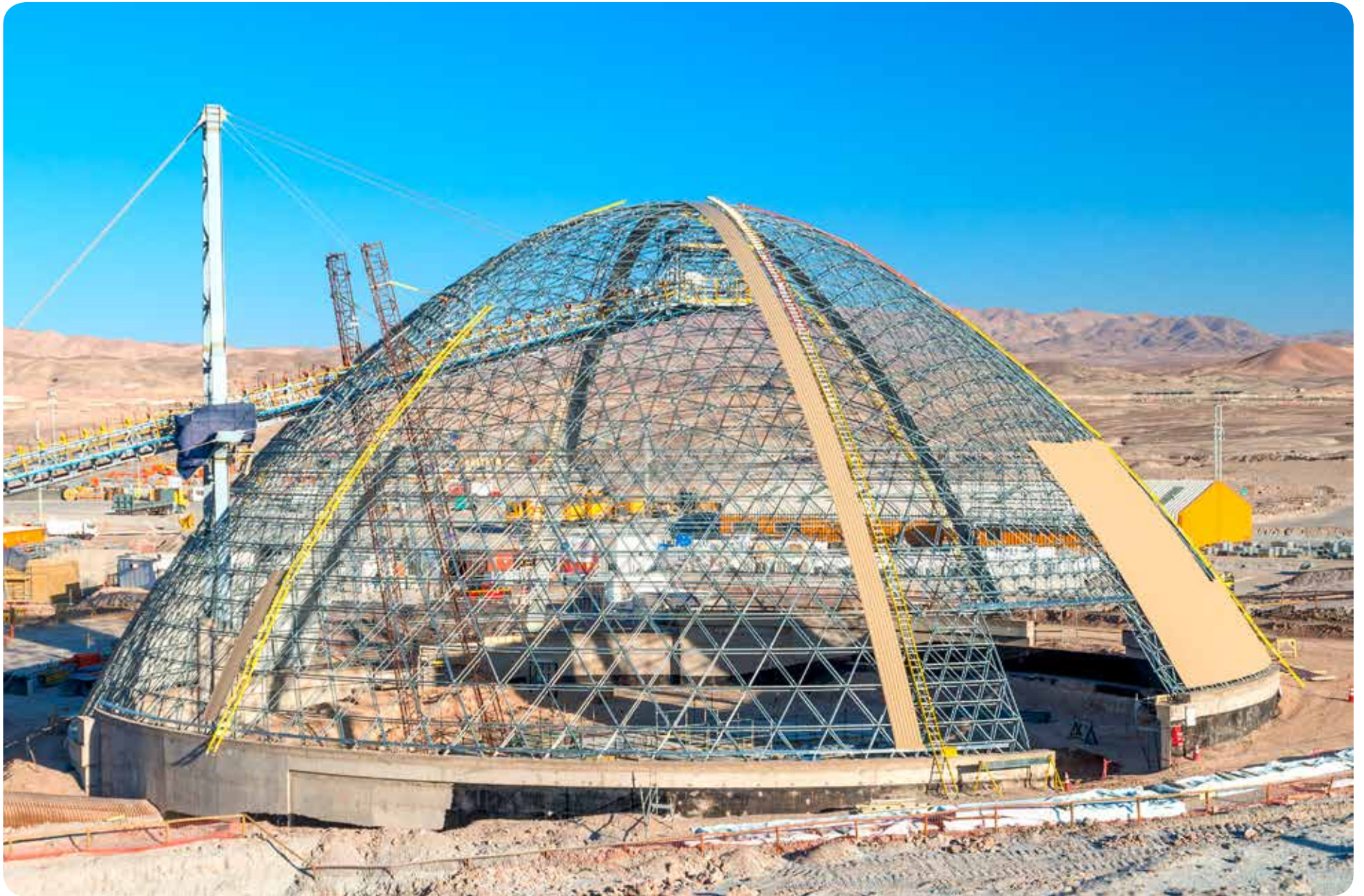
Domo proyecto Línea de Chancado 2º y 3º Minera Centinela - Sierra Gorda
