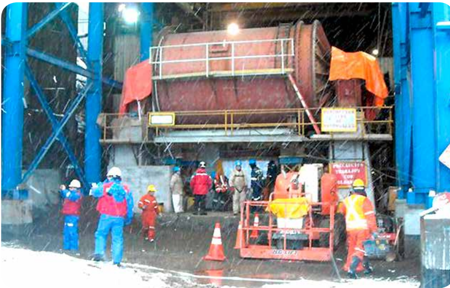
Montaje molino de bolas SCM El Toqui
