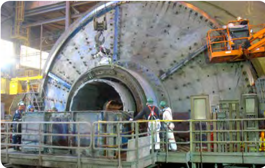
Reparación molino SAG N°1 - Minera Candelaria
