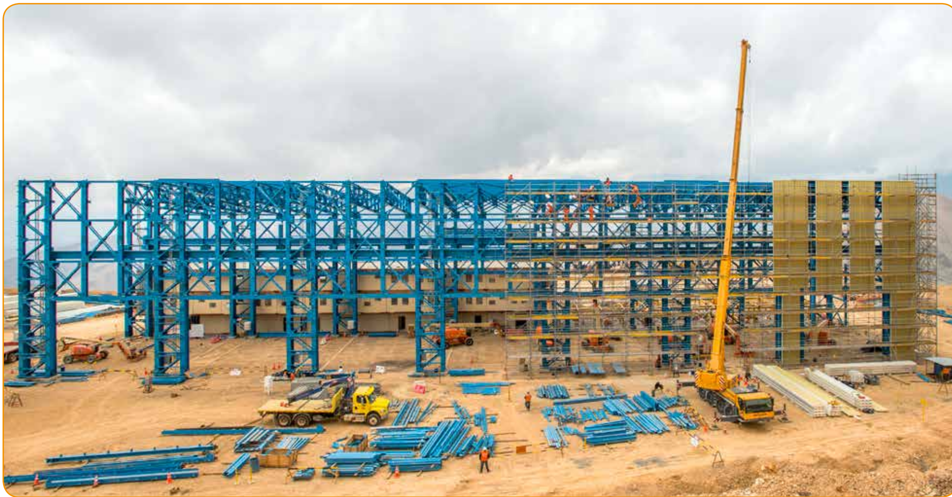
Montaje de estructuras y revestimiento taller de camiones, Rajo Sur
