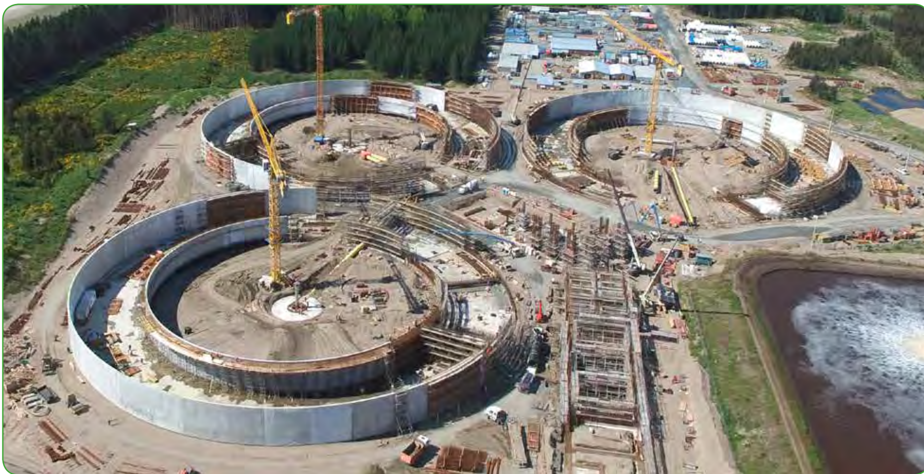
Montaje civil-electromecánico planta Tratamiento de Efluentes, Celulosa Arauco
