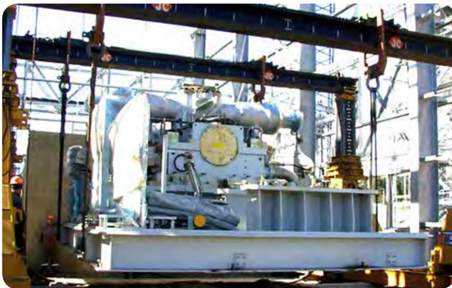
Montaje Turbogenerador Diesel 10 MW, Arauco Planta Itata
