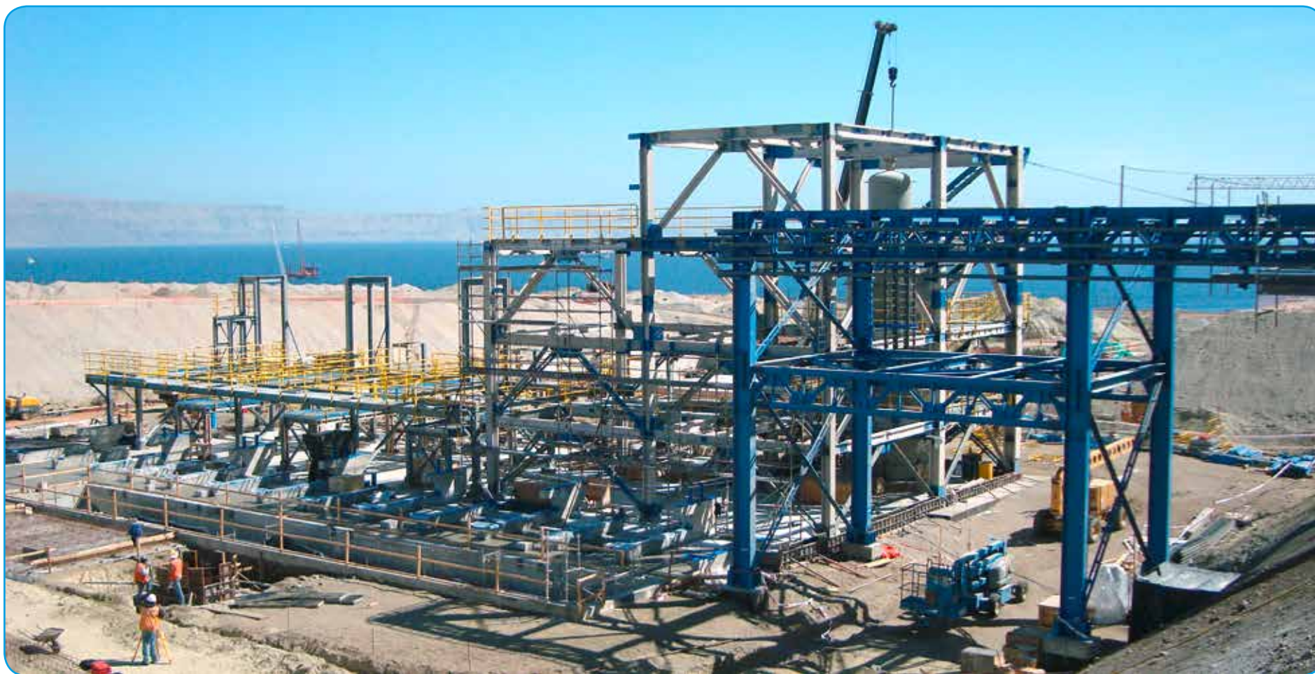
Obras Civiles y montaje electromecánico Planta GNL Mejillones - Bahía de Mejillones
