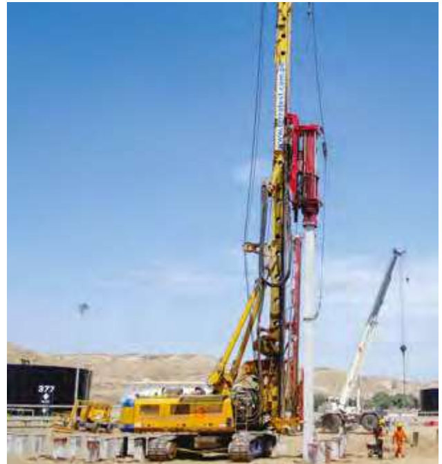
PILOTES EN PROYECTO REFINERÍA TALARA, TALARA – PERÚ
