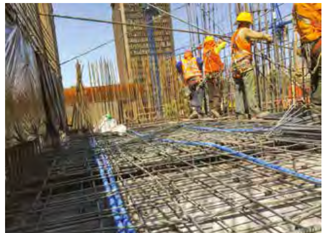
LOSAS POSTENSADAS CENTRO CULTURAL GABRIELA MISTRAL ETAPA II, SANTIAGO – CHILE
