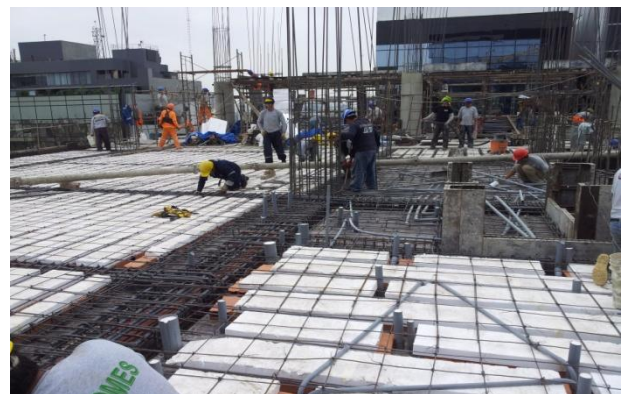
Losas postensadas edificio Eureka - Perú
