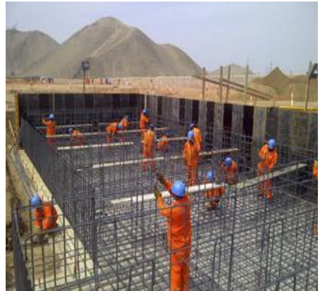
Caldera de Ciclo Simple, Siemens - Perú. Proyecto en el que participa Echeverría Izquierdo Montajes Industriales.
