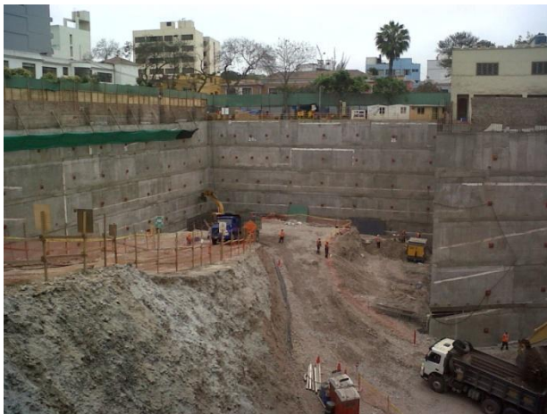
Anclajes postensados para Muro Anclado – Edificio de oficinas Pardo y Aliaga, Perú
