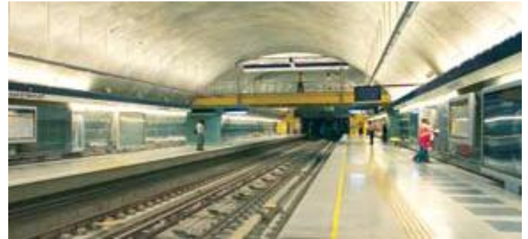
Obras línea 4 Metro Puente Alto: Viaducto, Talleres y Estación Puente Alto
