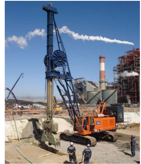
Muro Pantalla Central Termoeléctrica Ventanas III
