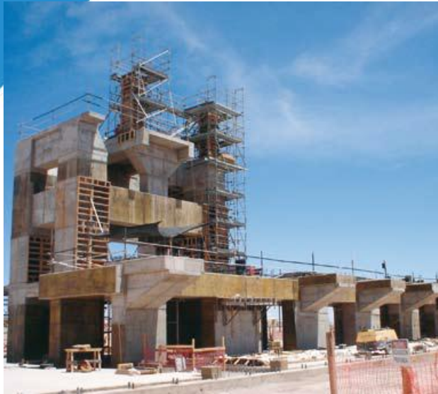
Obras Civiles Minera Spence
