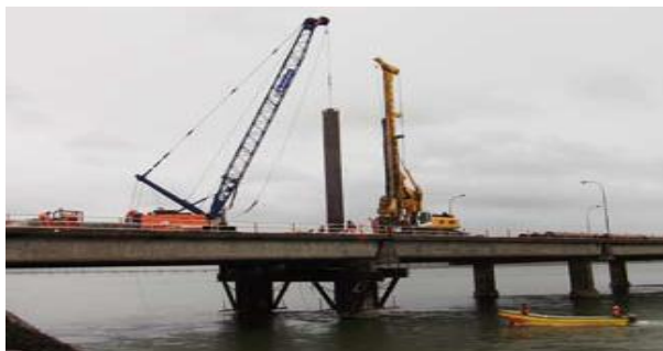
Reparación Puente Juan Pablo II
