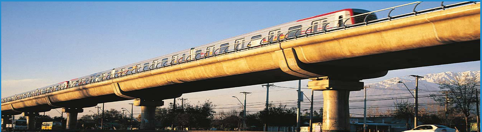
Obras Línea 4 Metro Puente Alto: Viaducto, Talleres y Estación Puente Alto
