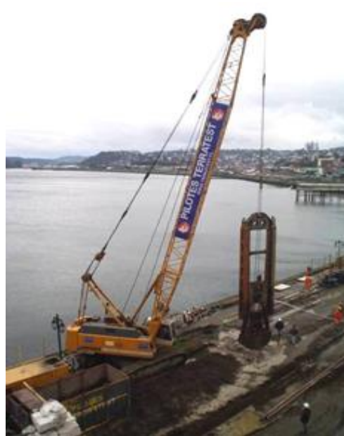
Muro Pantalla Paso Inferior Palcaví, Concepción
