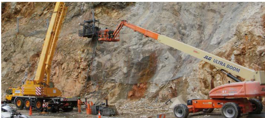
Anclajes Pasivos en Roca, Paso Internacional Pehuenche
