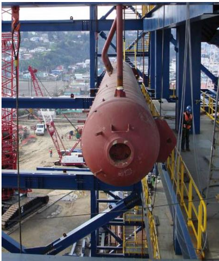
Izaje Caldera Bocamina
