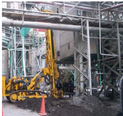
Micropilotes Autoperforantes, Planta CMPC Laja
