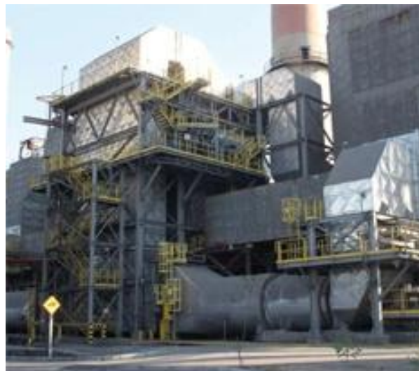
Planta de Desulfurización Ventanas, AES Gener
