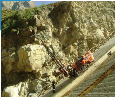
Inyecciones de impermeabilización en roca, Embalse Ancoa
