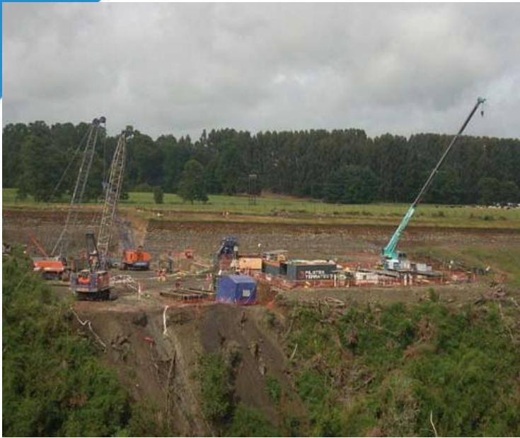
Muro Pantalla Central Hidroeléctrica Rucatayo
