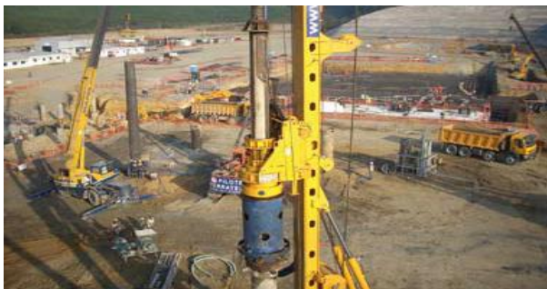
Pilotes pre-excavados Central Termoeléctrica Puerto de Coronel
