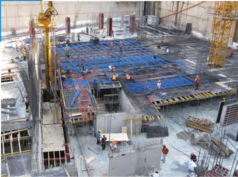
Losa Postensada Edificio de las Artes
