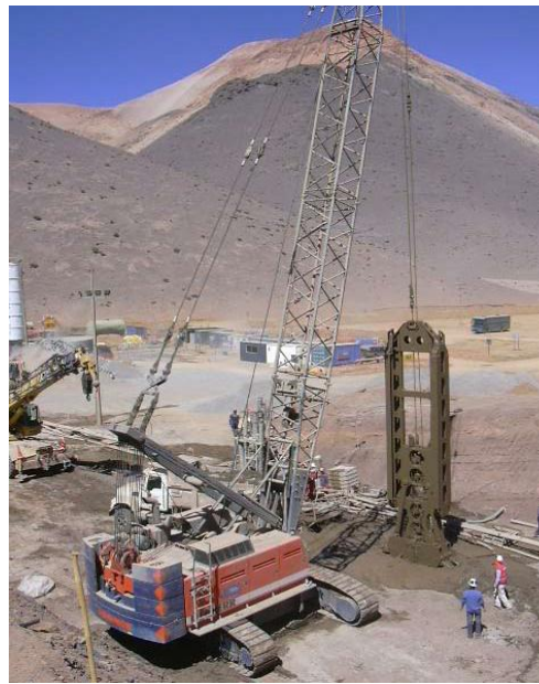
Muro Pantalla Plástica Mina la Coipa
