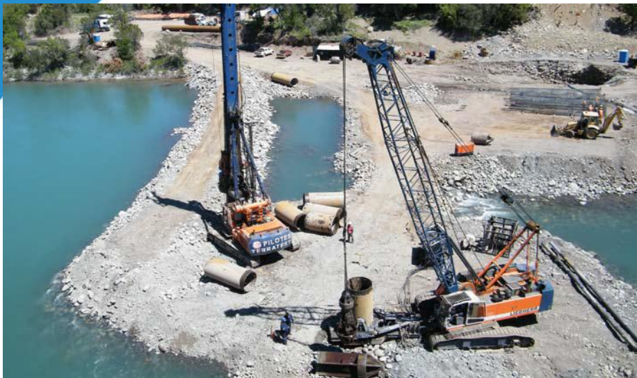
Pilote pre-excavados Puente San Fabián
