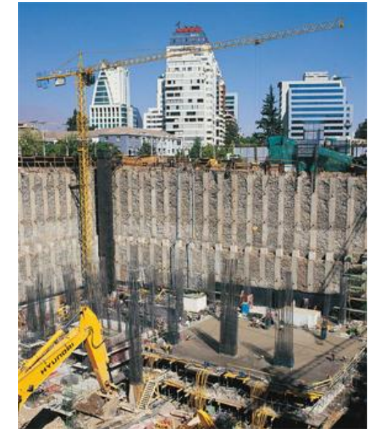
Anclajes postensados Edificio Isidora 3000
