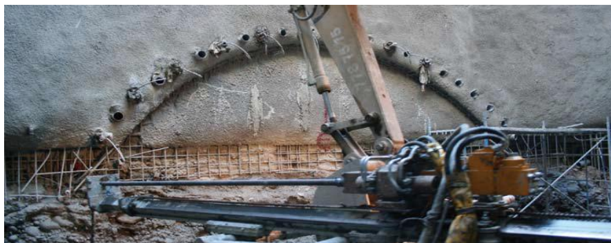
Micropilotes línea 4 Metro de Santiago
