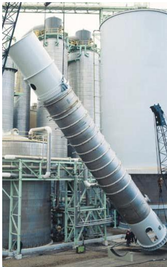
Planta de Celulosa Pacífico, CMPC Celulosa S.A.
