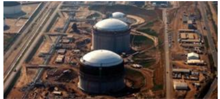
Estanques GNL Quintero
