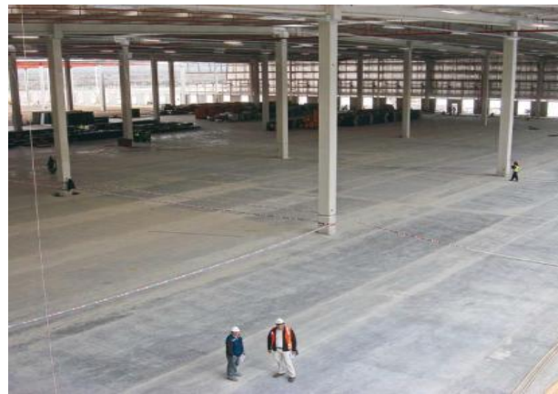
Radier Centro de Distribución Unimarc
