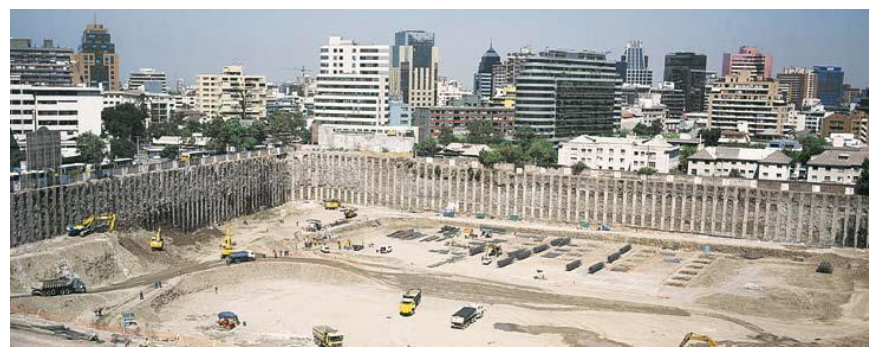
Anclajes Postensados Mall Costanera Center
