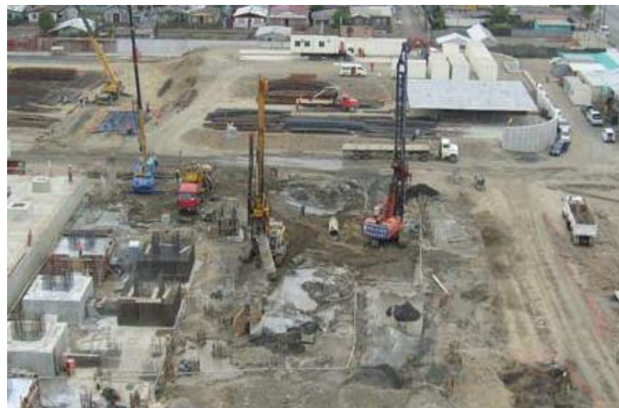
Pilotes pre-excavados Central Termoeléctrica Bocamina II
