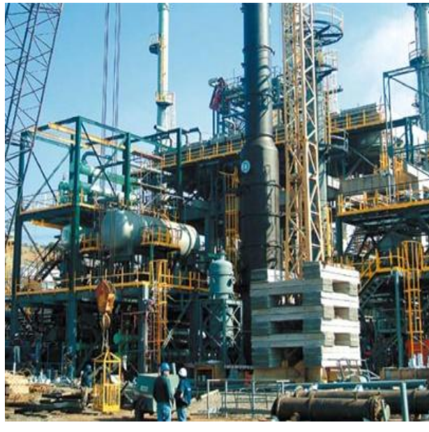
Refinería de Petróleo Concón
