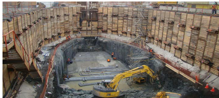
Muro Berlínés y Pantalla Plástica CWS Pimp It EN Central Termoeléctrica Puerto Coronel
