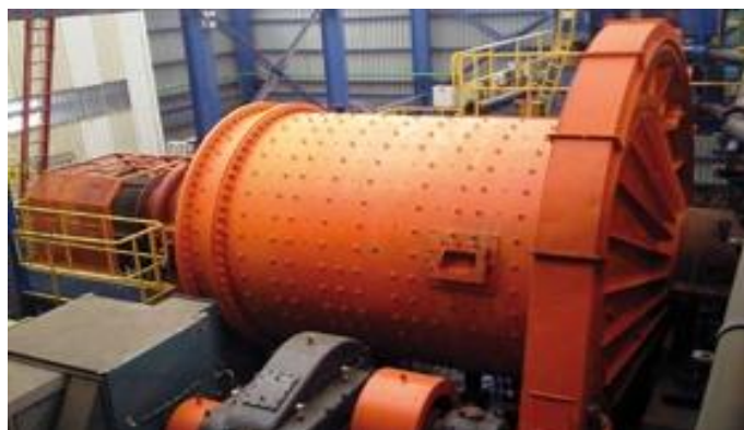
Planta de Pasta y Ampliación de Molienda Minera el Toqui
