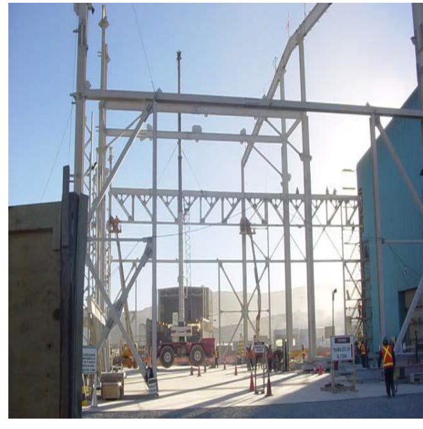
Ampliación Taller de Camiones Minera Escondida
