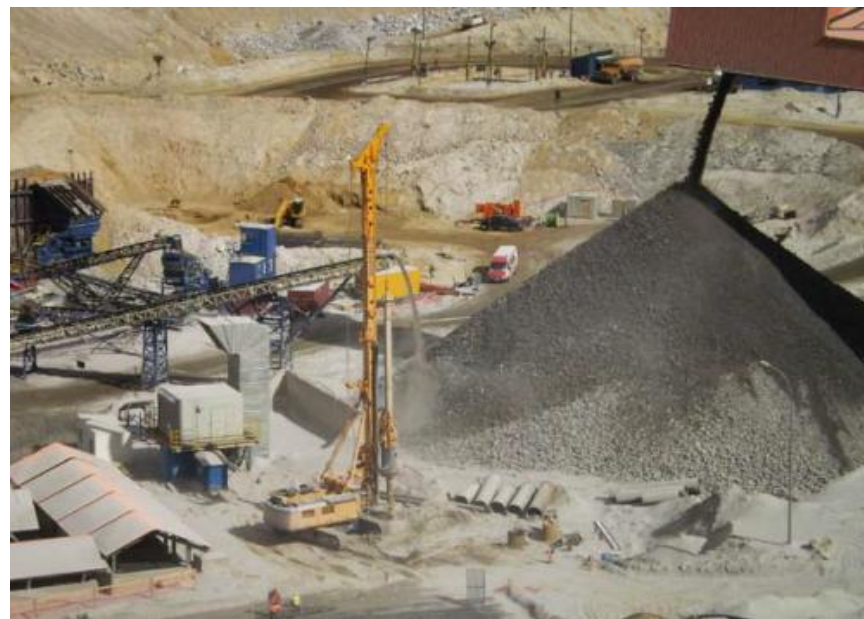
Pilotes pre-excavados Minera Los Pelambres
