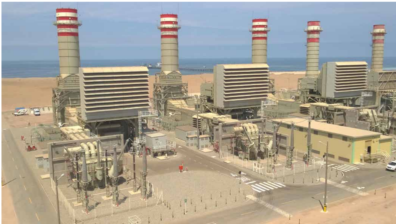
MONTAJE ELECTROMECÁNICO Y BOP NODO ENERGÉTICO PLANTA ILO, PROVINCIA DE ILO – PERÚ
