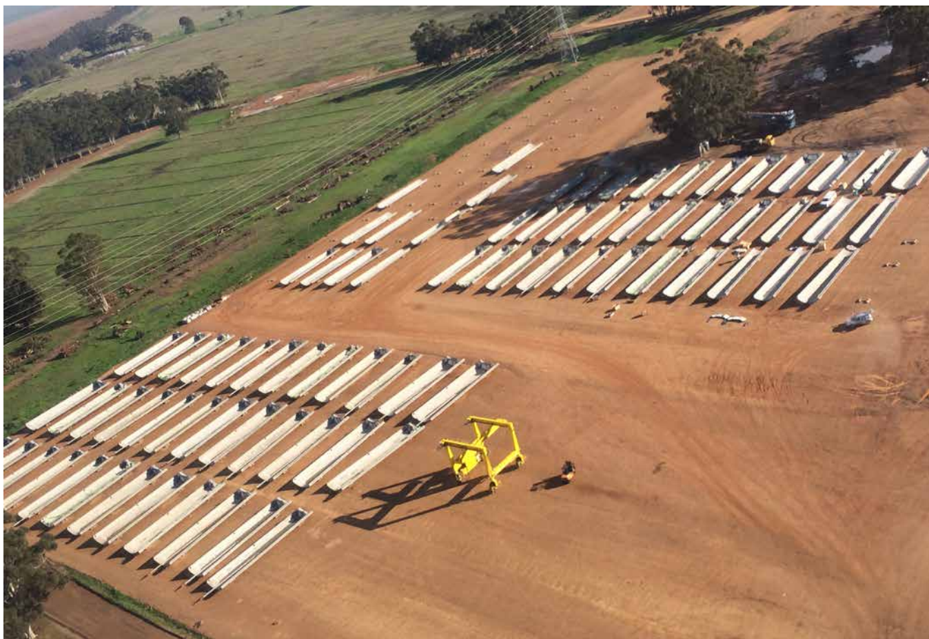
PREFABRICACIÓN Y SUMINISTRO DE PIEZAS DE HORMIGÓN ARMADO PARA 61 TORRES DE PARQUE EÓLICO SAN GABRIEL, COMUNA DE RENAICO – CHILE
