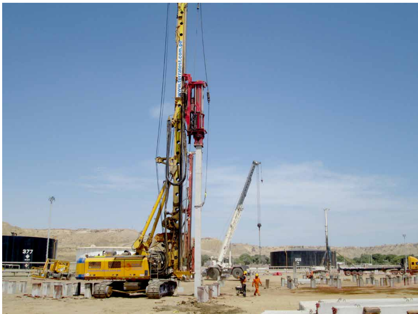
PILOTES EN PROYECTO REFINERÍA TALARA, TALARA – PERÚ
