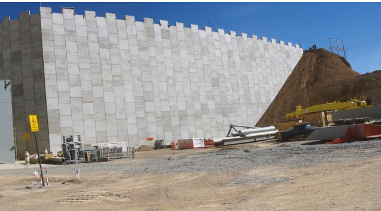
■ Muro de Tierra Retenida Minera Collahuasi
