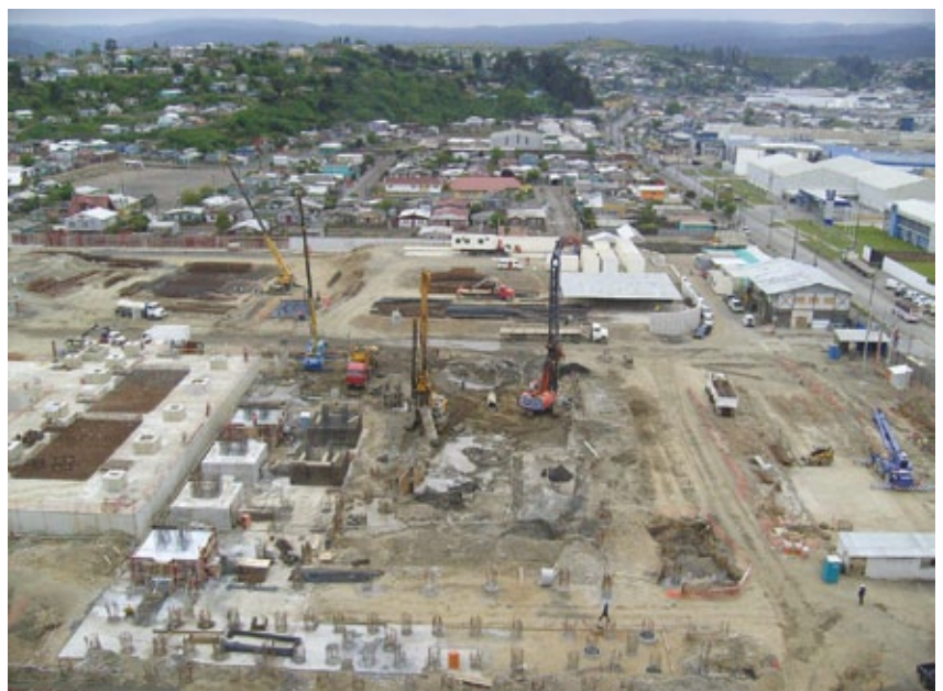
▀ Pilotes pre-excavados Central Termoeléctrica Bocamina II
