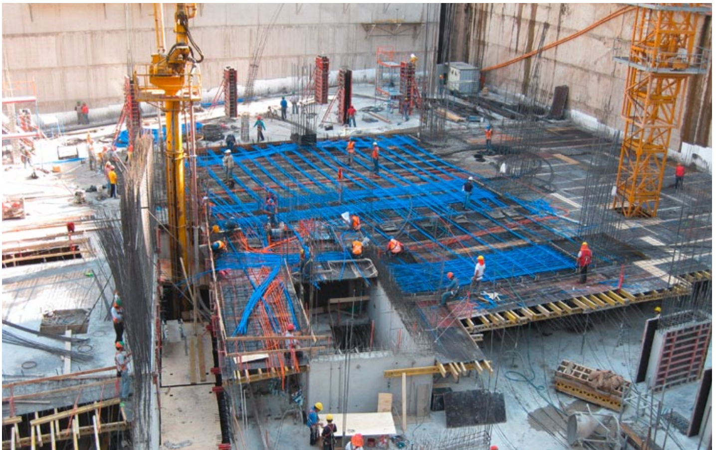
▀ Losa Postensada Edificio de Las Artes
