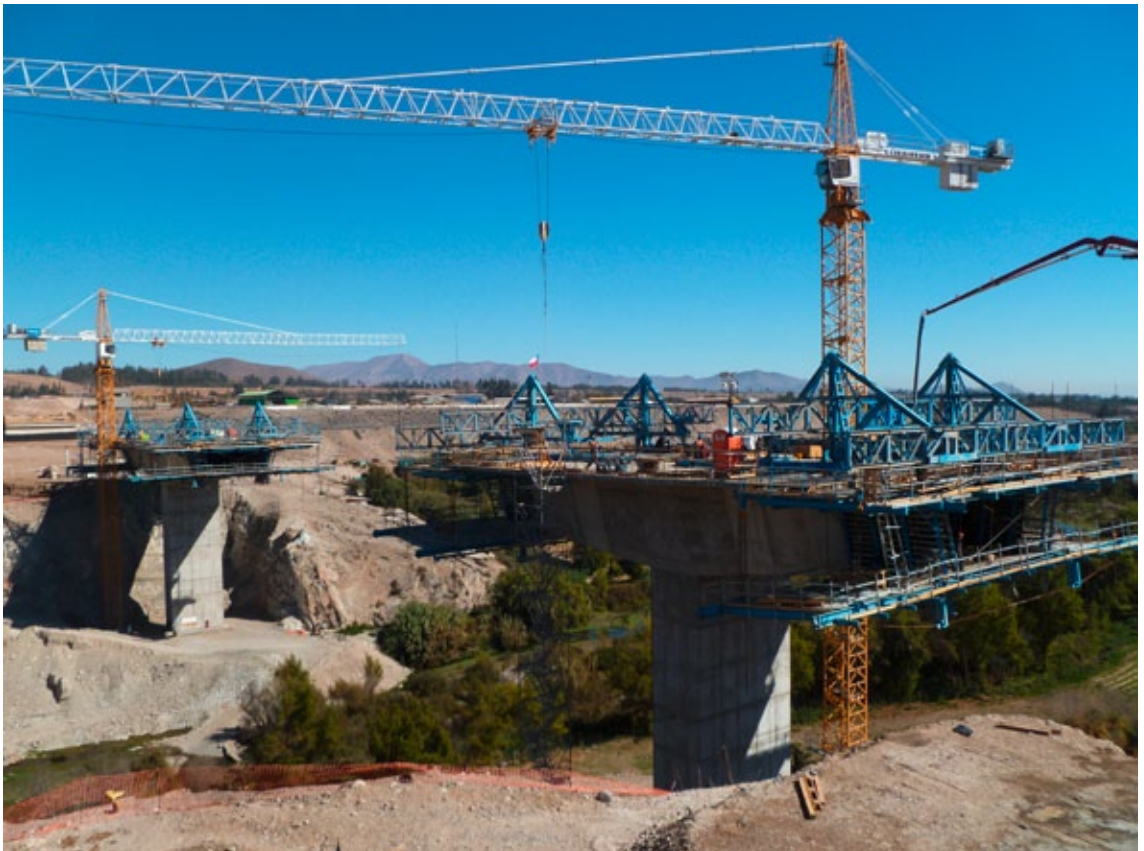
■ Tablero por voladizos sucesivos puente Huasco
