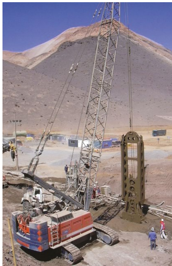
▀ Muro Pantalla Plástica Mina la Coipa
