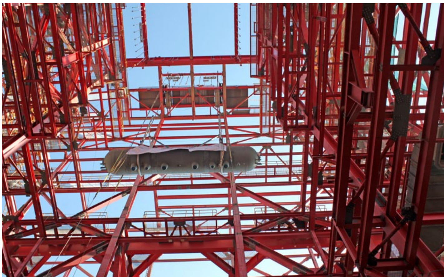
■ Izaje Domo Central Termoeléctrica Campiche
