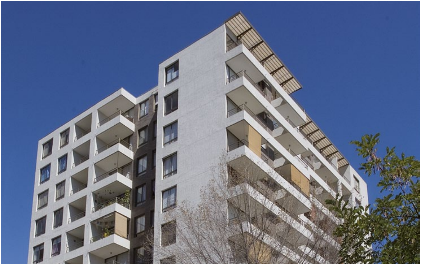
Edificio Manuel de Salas
