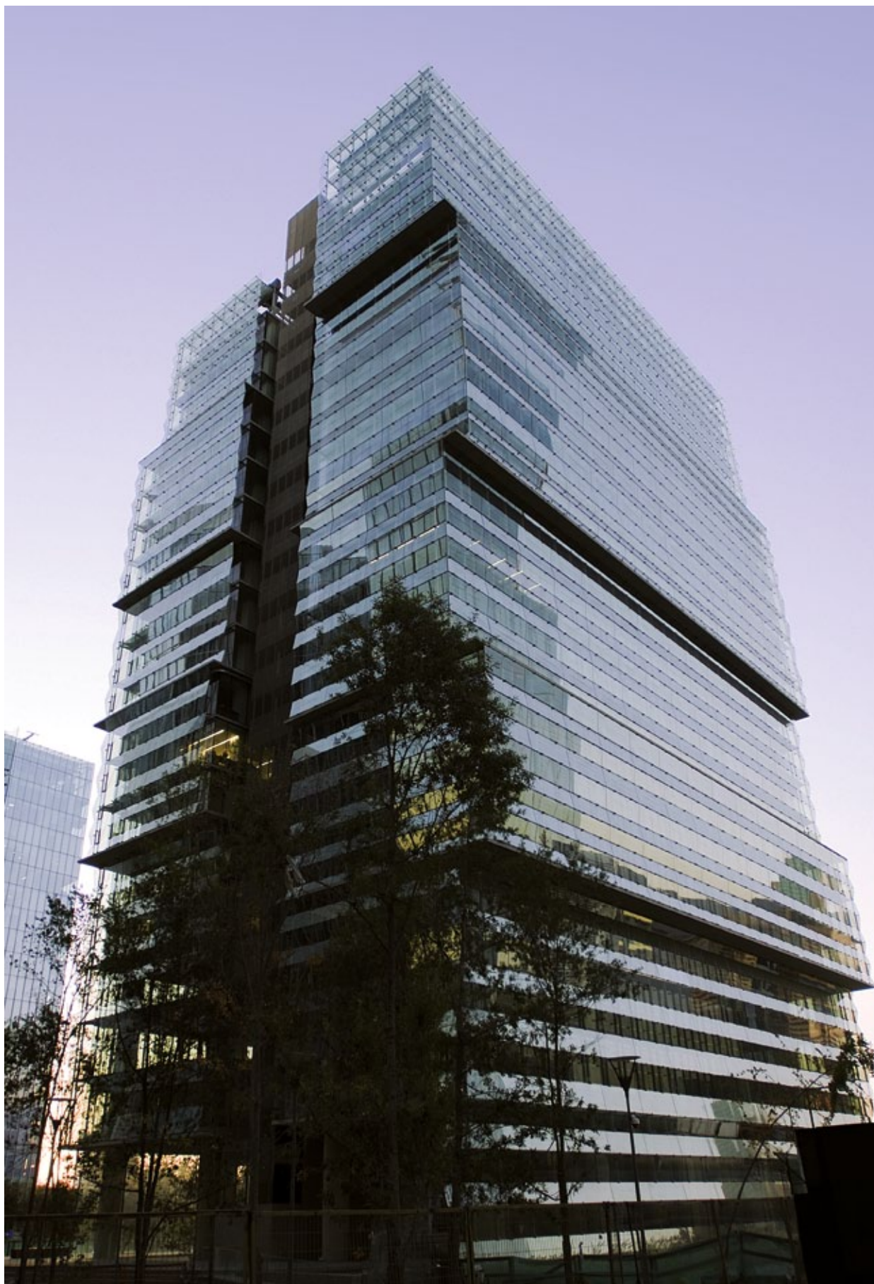
▀ Edificio Arrau, Nueva Las Condes
