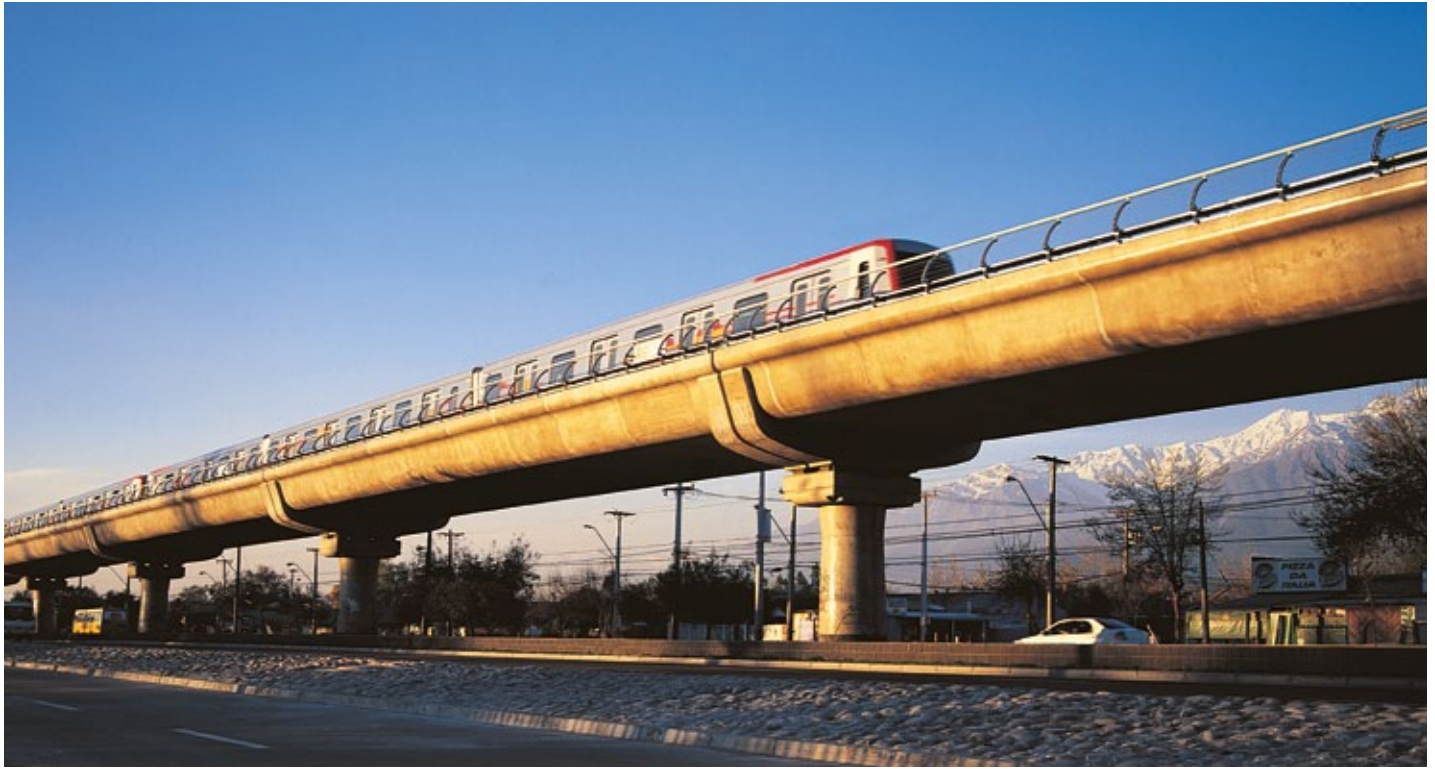
▀ Viaducto Línea 4 Metro Puente Alto
