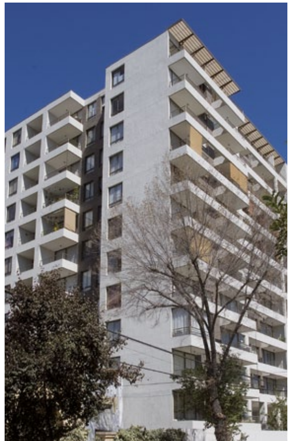
Edificio Manuel de Salas
