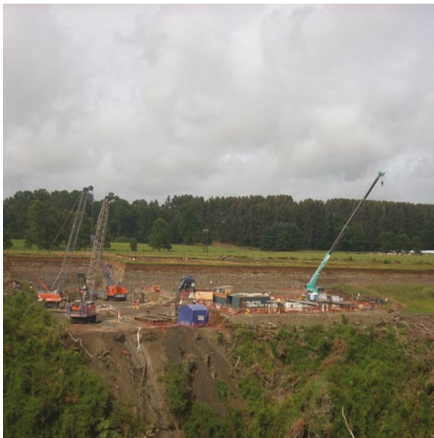
▀ Muro Pantalla Central Hidroeléctrica Rucatayo
