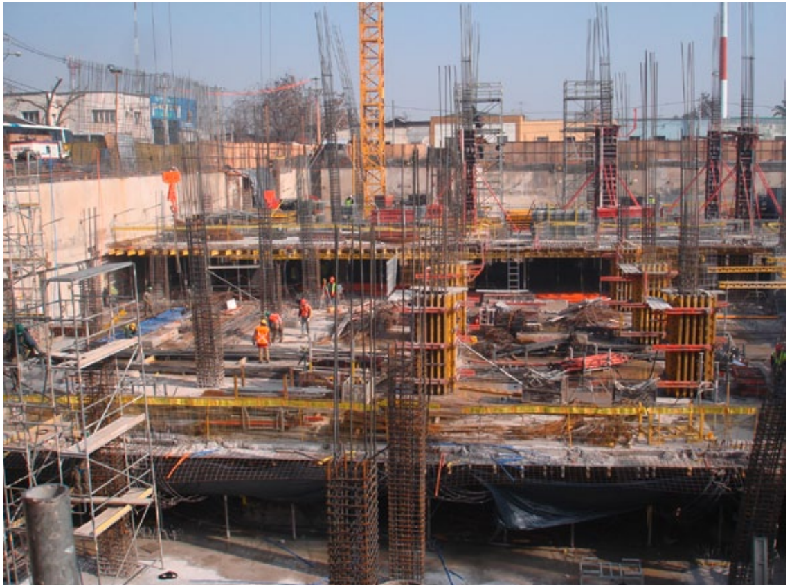
■ Losa Postensada Mall Plaza Alameda
