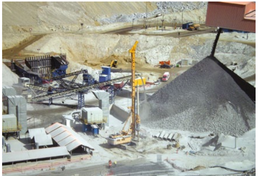
▀ Pilotes pre-excavados Minera Los Pelambres
