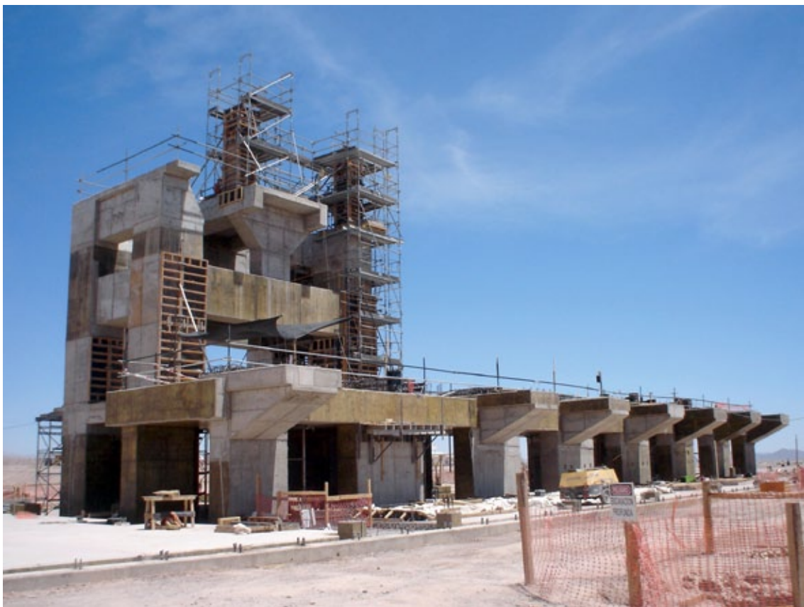
▀ Obras Civiles Minera Spence
