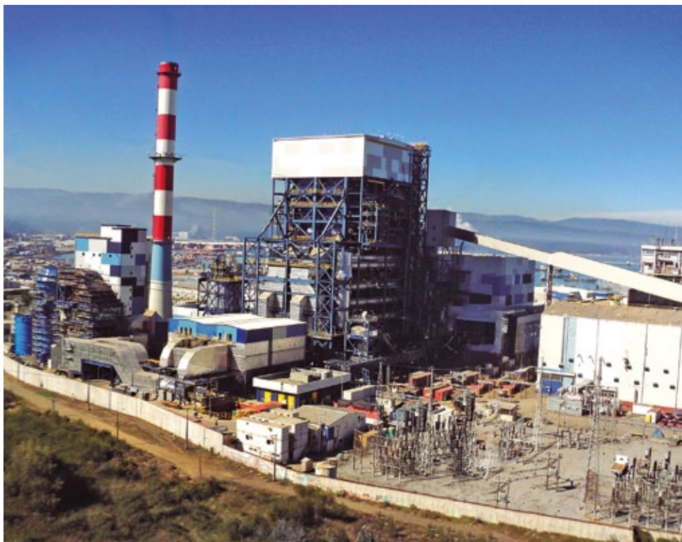
Central Termoeléctrica Bocamina II Endesa
