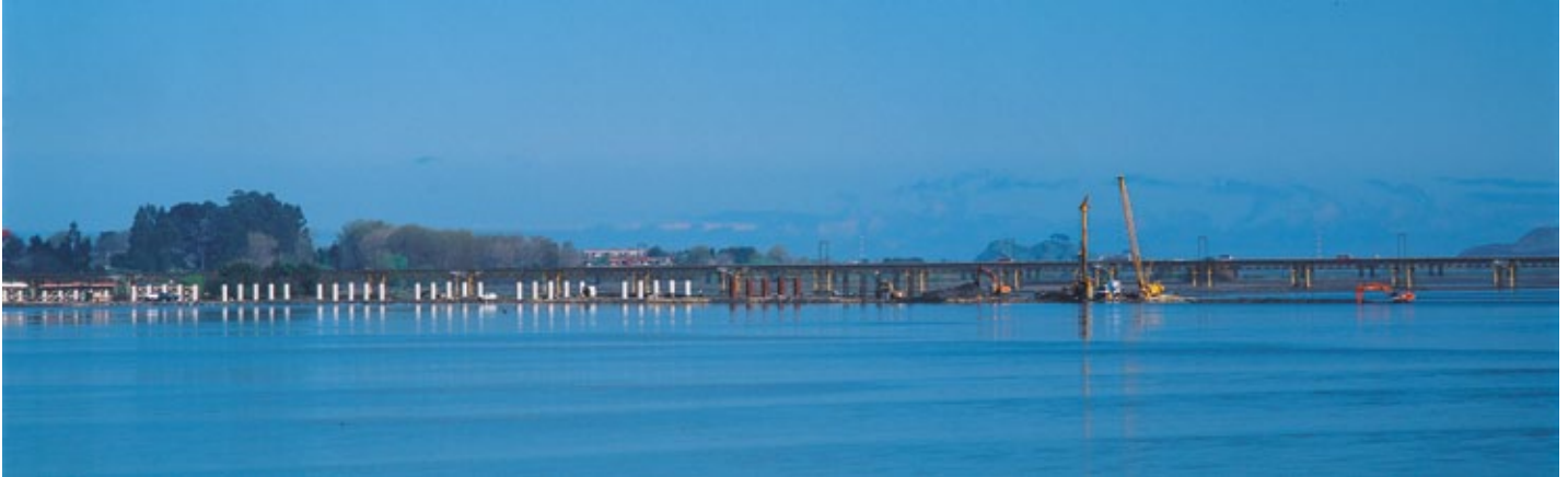
▀ Pilotes pre-excavados Puente Llacolén; BíoBío Concepción
