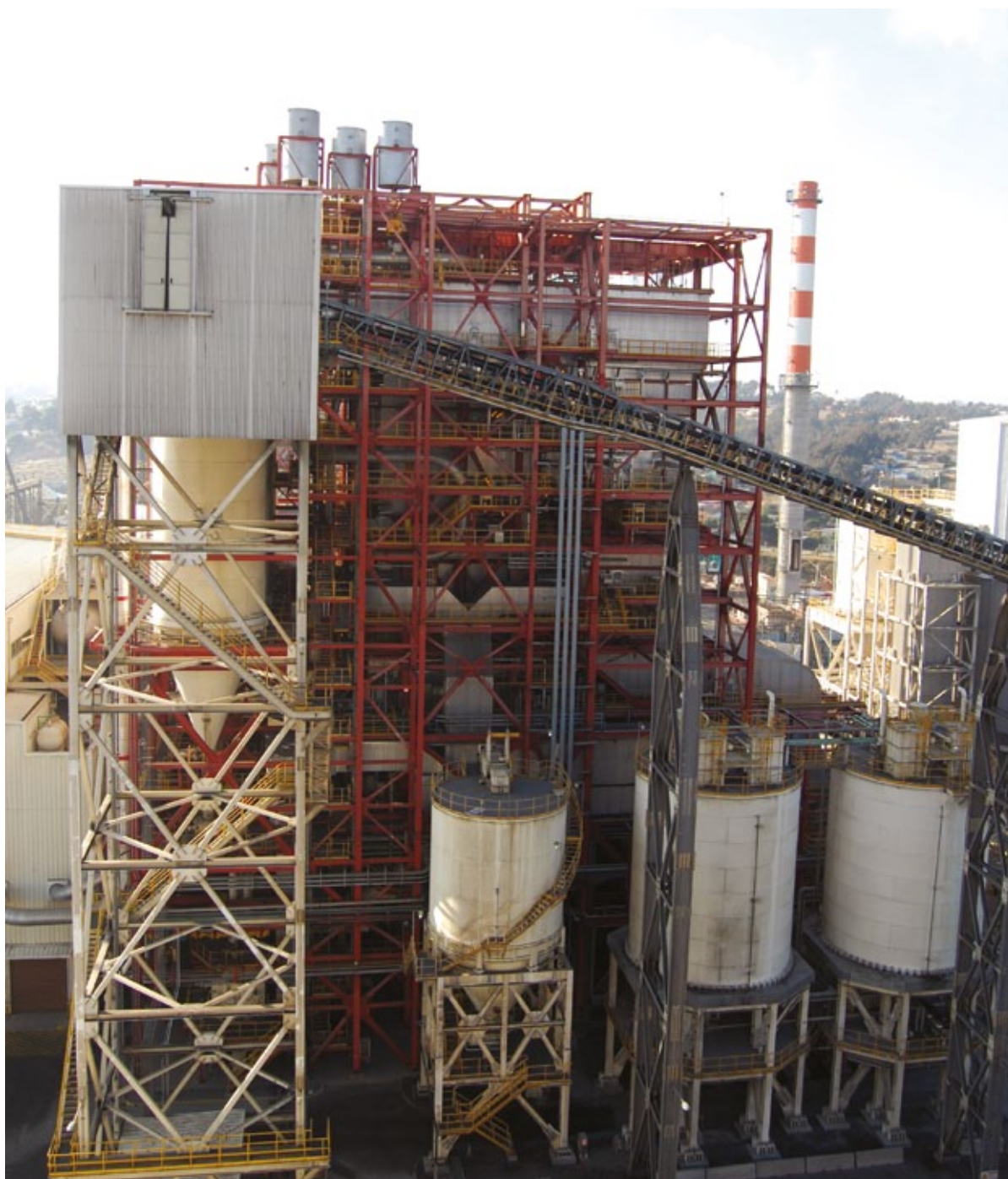
Central Termoeléctrica Ventanas II AES Gener
