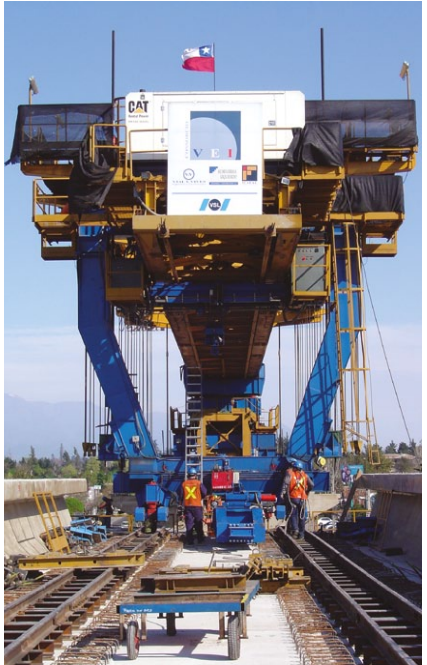
▀ Viaducto línea 4 Metro de Santiago
