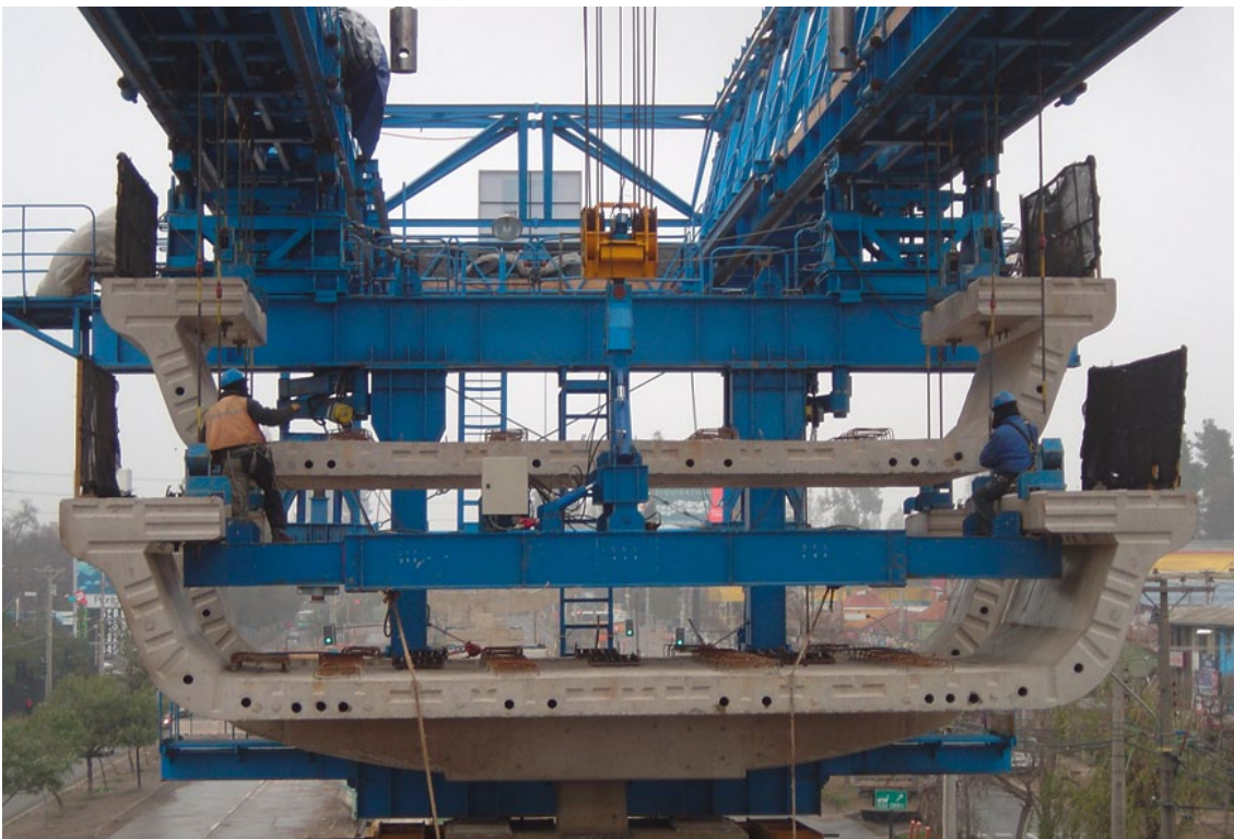
▀ Viaducto Línea 4 Metro de Santiago
