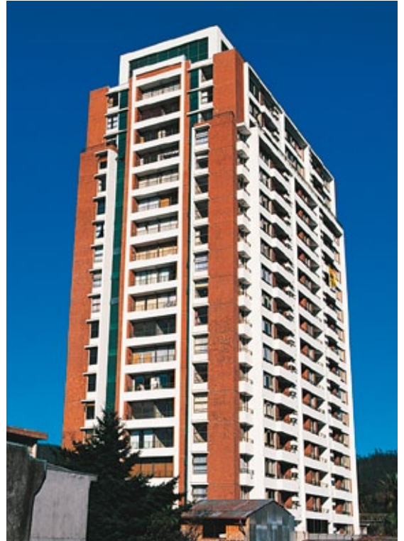
Edificio Víctor Lamas
