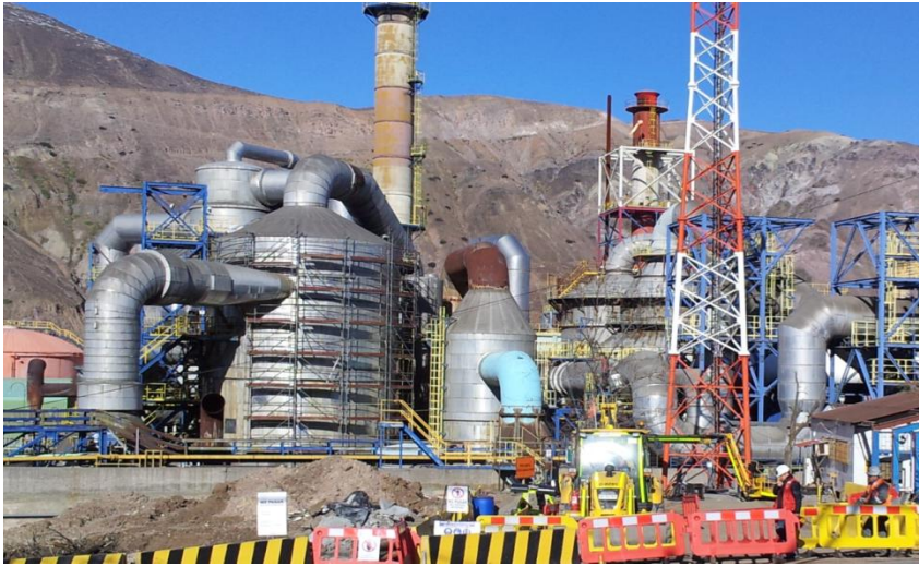
Construcción y Montajes obras tempranas reducción emisiones. Codelco
