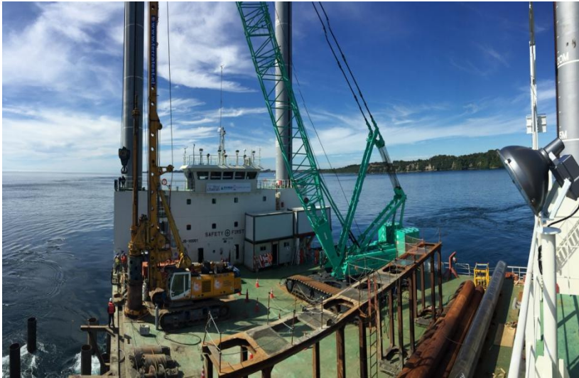
Obras y equipos en Puente del Chacao
