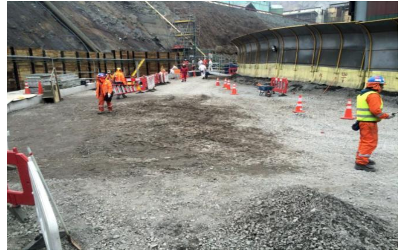
Ampliación nave convertidores Codelco Fundición Caletones
