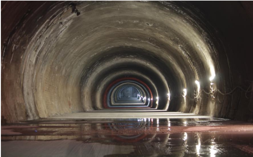
Obras Civiles de pique, galerías y túneles de Tramos 2 y 3 Norte. Línea 3 del Metro de Santiago.
