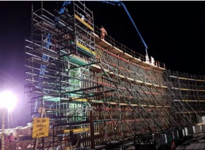
Planta tratamientos Efluentes Arauco. Hormigonado de muros.
