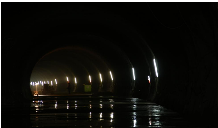
Obras Civiles de pique, galerías y túneles de Tramos 2B, 3 y 4. Línea 6 del Metro de Santiago.
