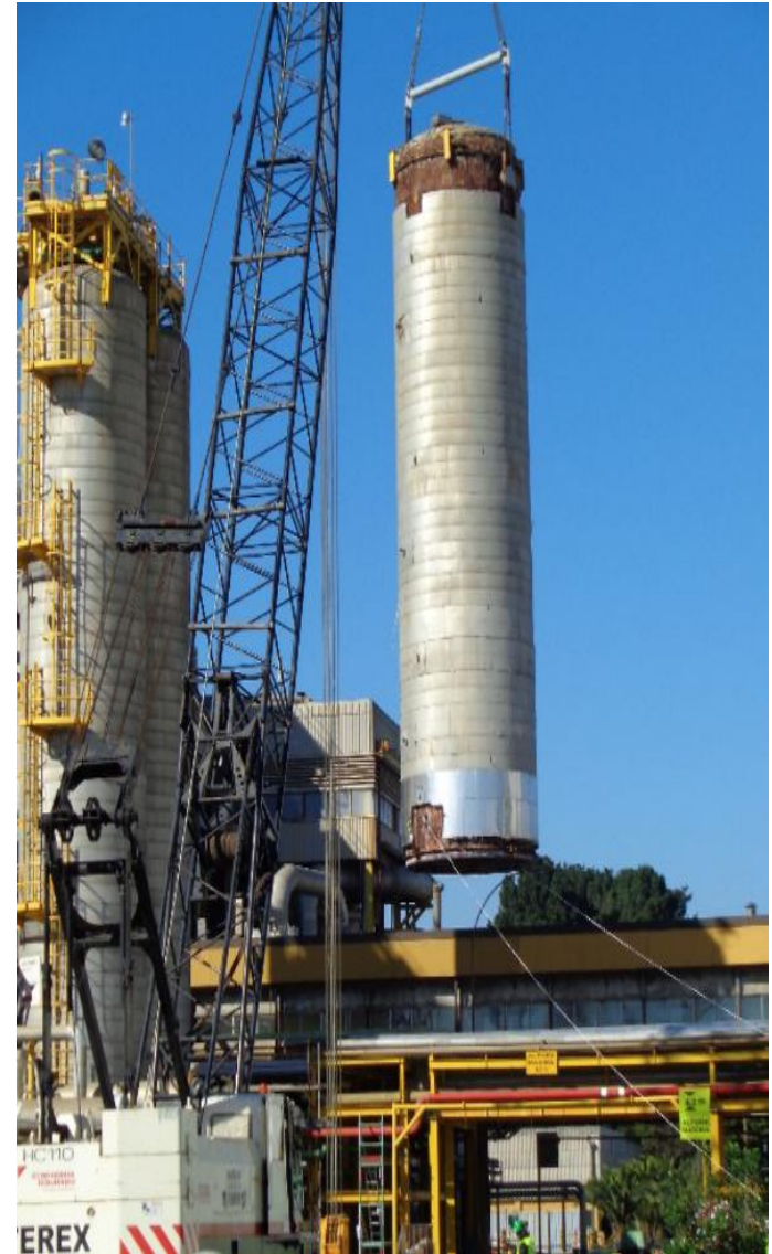
Upgrade Caldera recuperadora Arauco
