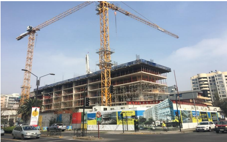
Edificio Los Leones. Santiago, Chile.
