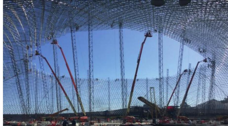
Obras civiles y montaje Domo geodésico para techado de canchas de carbón sur de Central Bocamina, Enel.
