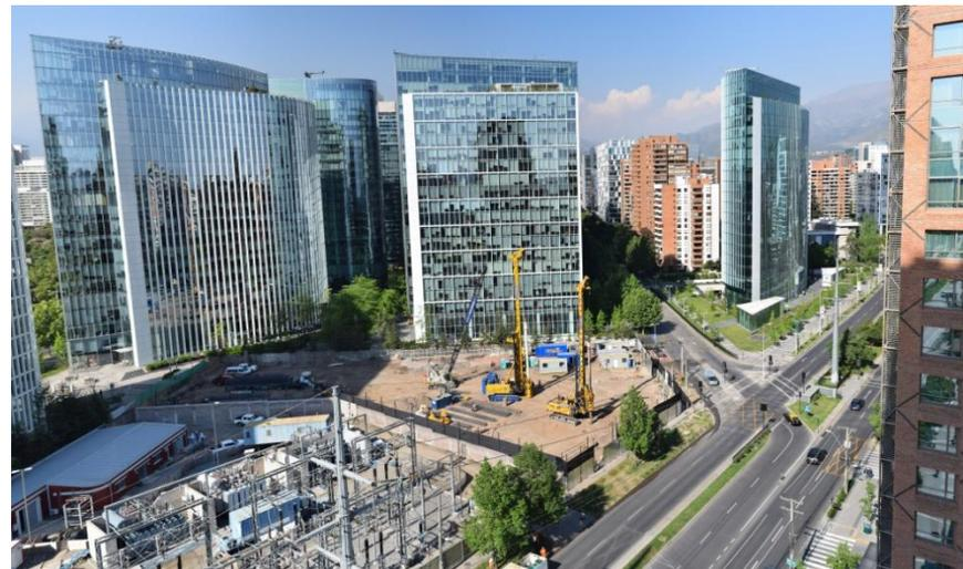
**Entibación con pilotes y anclajes Edificio Cerro El Plomo-
