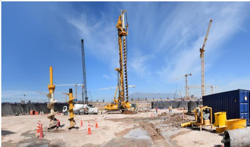
**Pilotes CFA, bajo lodos y ensayos de carga en ampliación
