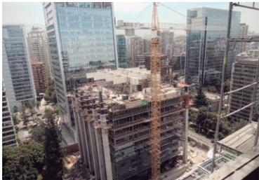
Losa Postensada y Columnas Postensadas. Edificio Alcántara 99 - Santiago
