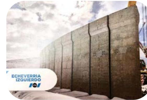
Estructuras Segmentadas es una innovación de fabricación de muros y losas modulares transportables a obra, los cuales son montados para luego poder postensar y así lograr estructuras monolíticas. La gran diferencia que tiene esta tecnología con otros competidores radica en el valor añadido al momento de realizar la unión, dado que se pueden eliminar las juntas húmedas con el postensado, simplificando el proceso.
