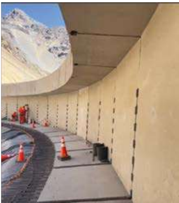
CLARIFICADOR LAGUNITAS, CODELCO.
