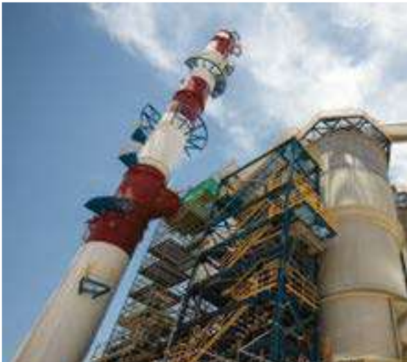
OBRAS CIVILES Y MONTAJES ELECTROMECAÁNICO PLANTAS ÁCIDO 3 Y 4 CHUIQCAMATA, CODELCO, CALAMA - CHILE
